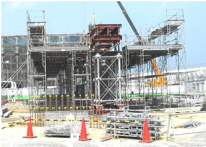
写真-3 RoRoシステム及び作業足場
