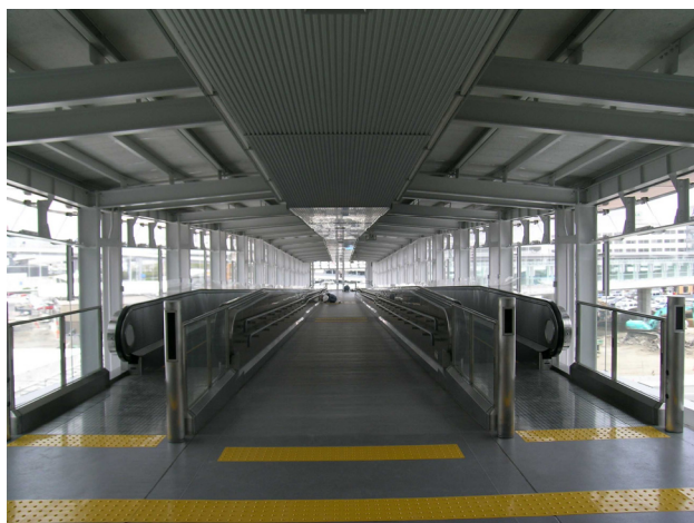
写真-18 連絡通路内部(平成18年4月)
