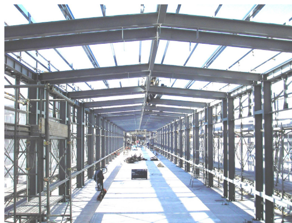
写真－11 鉄骨建て方完了
