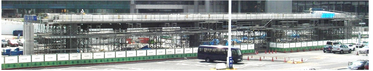
写真一 支保工及び外部作業足場設置状況 (II区)
