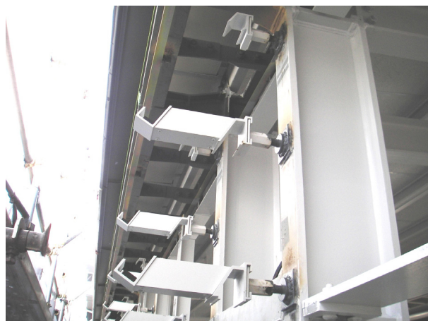
写真-14 GW 金物取付状況 (ルーバー部)
