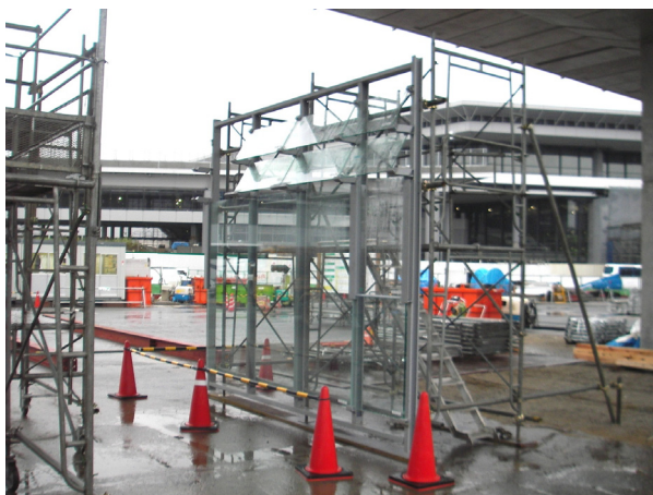
写真-12 ガラスモックアップ試験 上部: ガラスルーバー 下部: ガラスウォール
