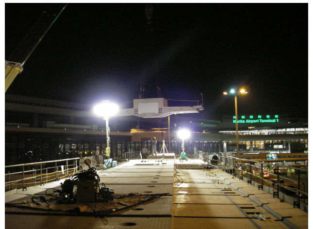
写真-4 夜間工事状況 (PC 梁架設)
