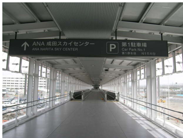
写真-19 連絡通路内部(平成18年4月)
