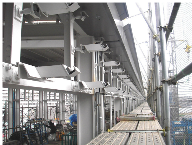
写真-15 GW 金物取付完了
