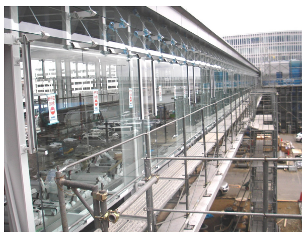
写真-17 ガラス取付完了
