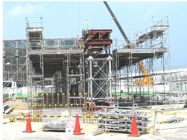
写真-6 支保工設置状況 (中央部は一般車両通行車線)
