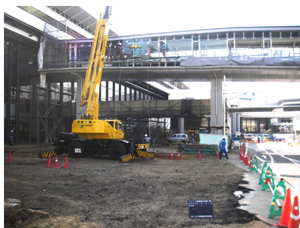
写真-16 ガラス (FL19) 取付状況 *重量: 380kg/枚により, クレーンにて取付
