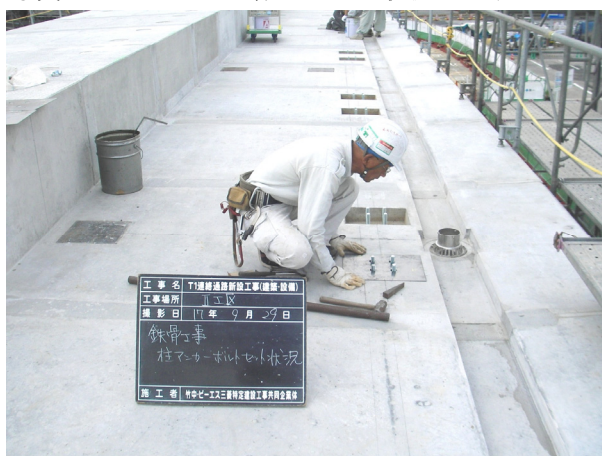
写真－8 PCaPC上アンカーボルトセット
