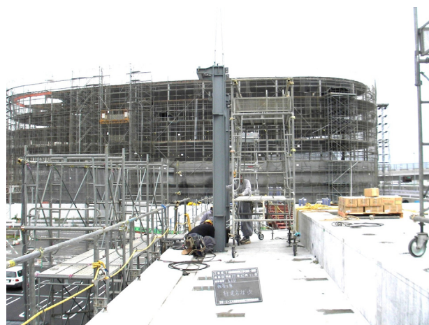
写真－9 鉄骨柱建て方状況
