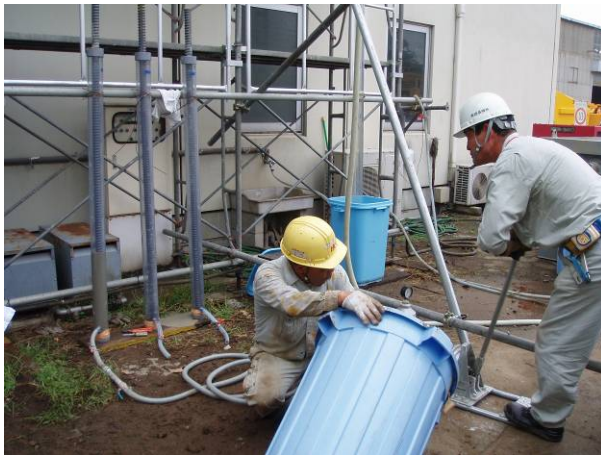
写真-1 マルチモルタル注入状況
