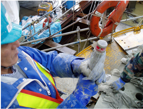
写真-14 注入口 養生状況
