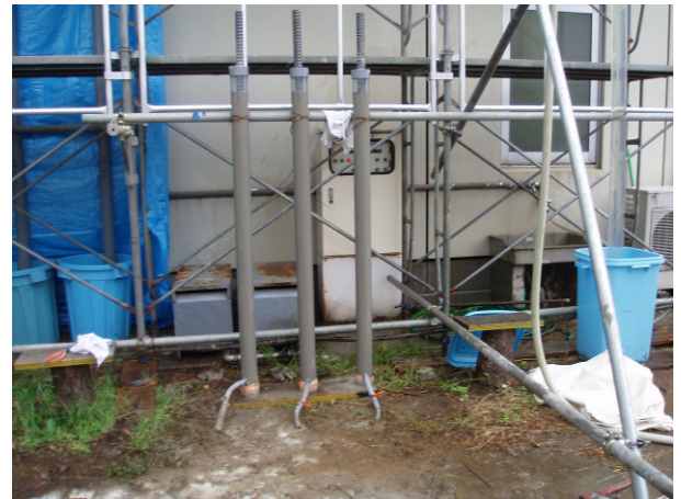
写真-2 マルチモルタル注入完了
