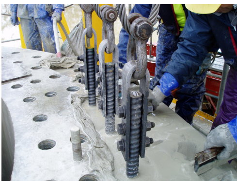
写真-18 鉄筋挿入状況
