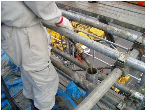
写真-4 注入状況 (トレミー管なし)
