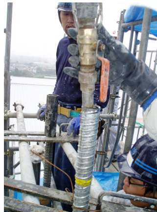
写真-5 注入状況 (トレミー管あり)
