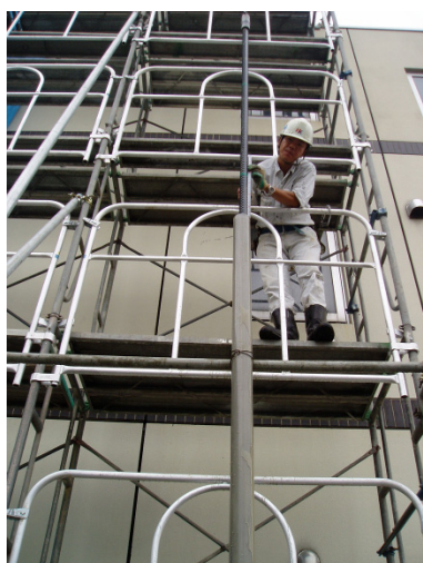
写真-12 鉄筋挿入状況
