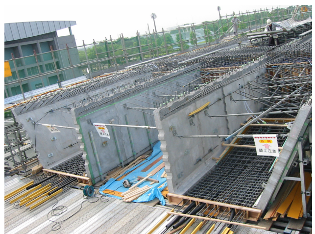
写真-3 全景（下床版打設前）
