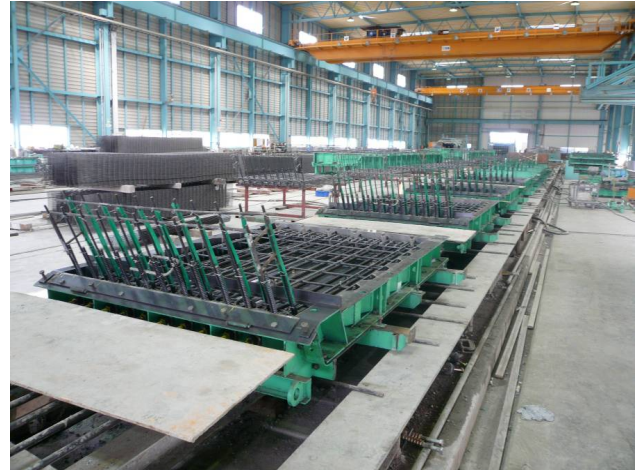
写真-2 プレテンションウエブ製作状況
