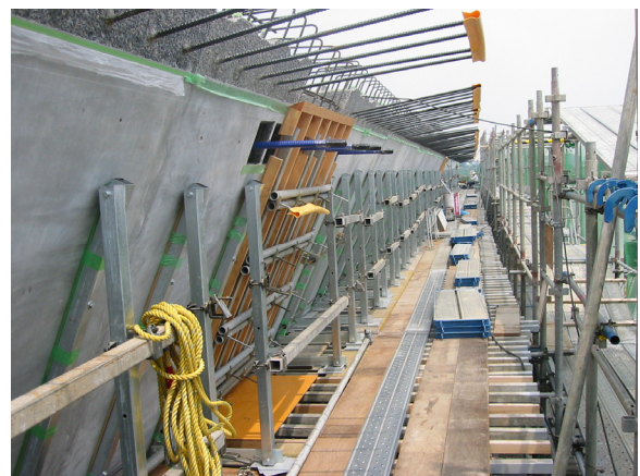
写真-6 Step3: 斜ウェブ側 (コンクリート打設前)
