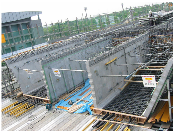
写真-5 Step3: 全景 (コンクリート打設前)
