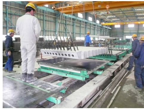
写真-4 脱枠状況
