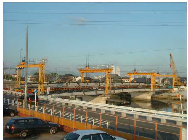
写真-1 プレビーム桁架設状況
