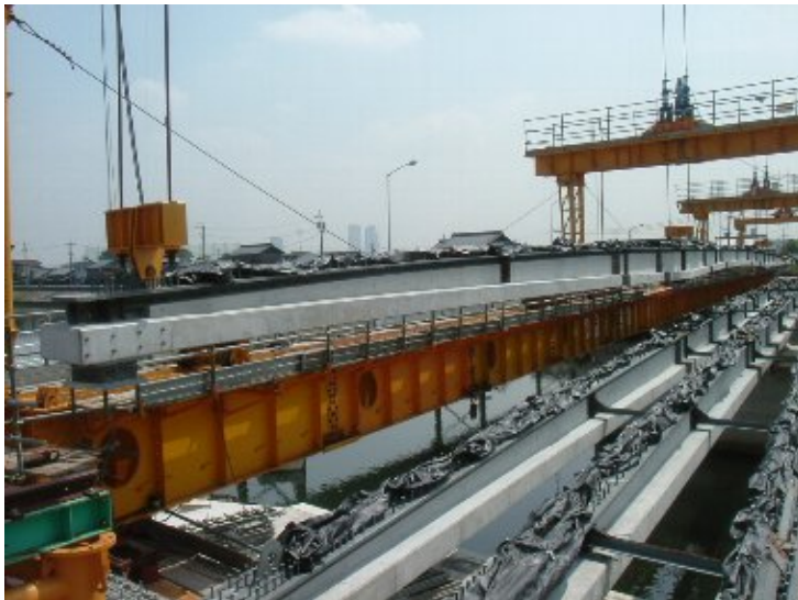
写真-2 主桁降下状況
