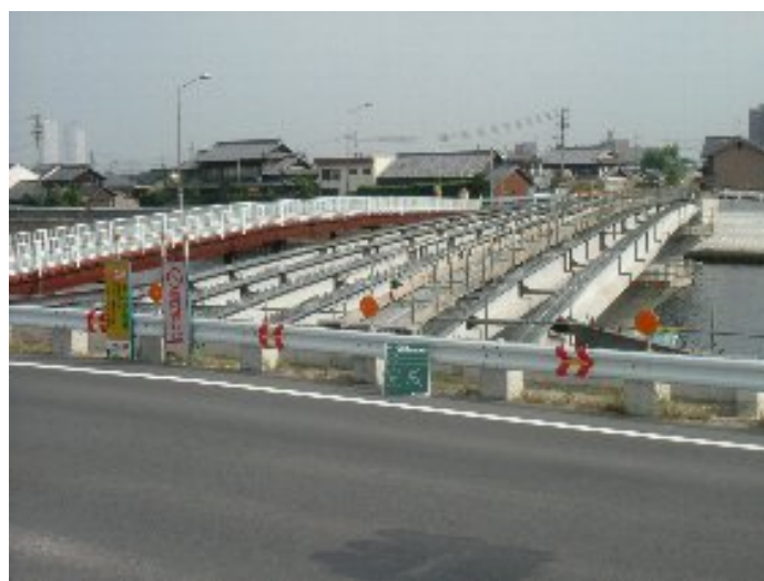
写真-6 架設完了
