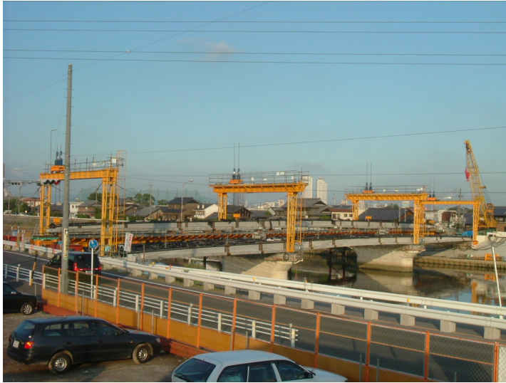
写真-1 プレベーム桁組立状況
