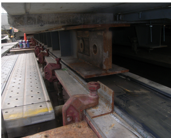
写真-2 横移動装置
