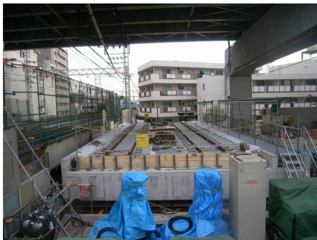
写真－6 中央径間新設桁（横取り前）
