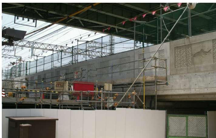
写真－8 城北川橋梁（架替え後、高欄施工後）
