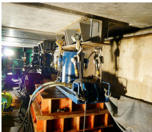
写真-4 ダウン用ジャッキ
