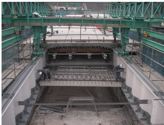
写真-2 PC板架設状況
