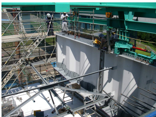
写真-3 波形鋼板架設状況
