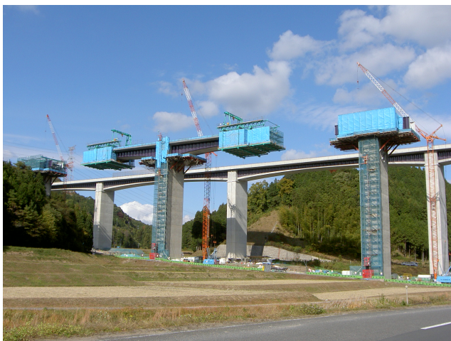
写真-1 杉谷川橋施工状況
