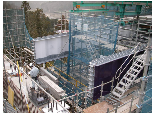
写真-4 側径間施工状況
