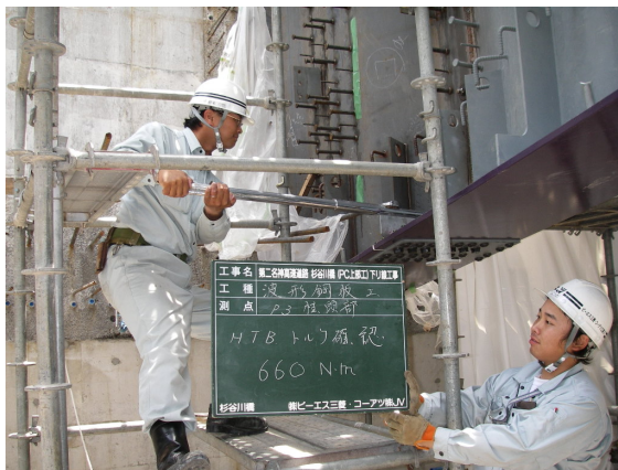
写真-3 フランジ添接ボルトトルク確認状況
