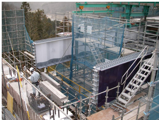
写真-13 側径間閉合部の施工
