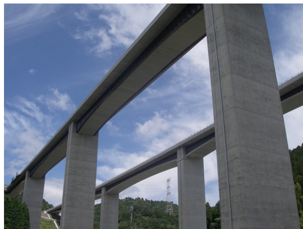
写真-15 完成写真(平成 19 年 7 月)
