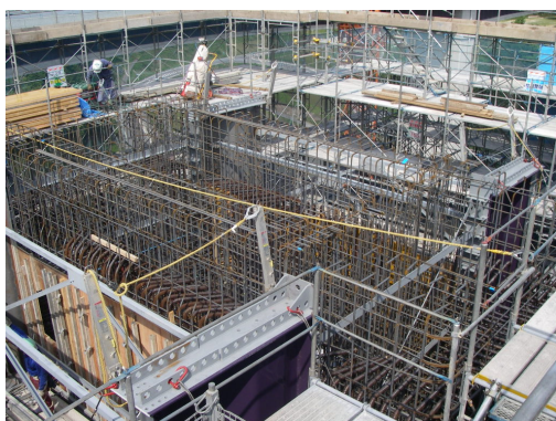
写真-8 柱頭部横桁 2 Lift 施工状況
