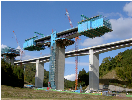
写真-10 張出施工状況
