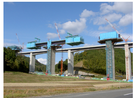
写真-1 杉谷川橋 (手前が下り線)
