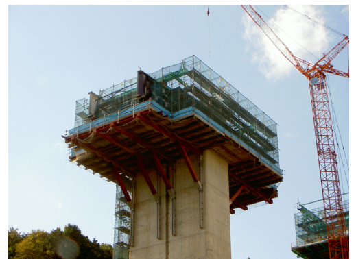
写真-7 柱頭部施工状況
