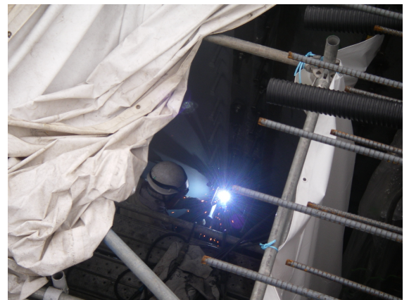
写真-4 ウェブ添接部現場溶接状況
