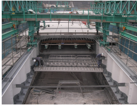
写真-5 PC板架設状況
