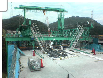
写真-12 張出架設機
