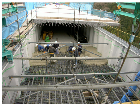
写真-14 中央閉合部施工状況
