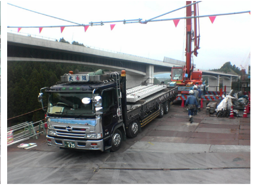
写真-6 PC板現場搬入状況
