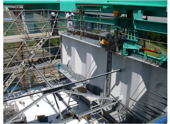
写真-2 波形鋼板架設状況
