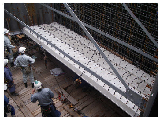
写真-9 柱頭部下床版施工状況
