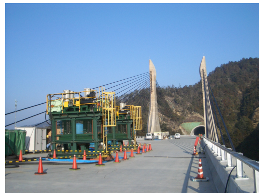
写真-2 起振機設置状況
