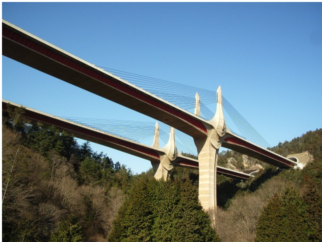
写真-1 近江大鳥橋完成写真
