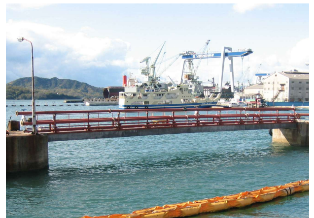
写真-3 完成状況
