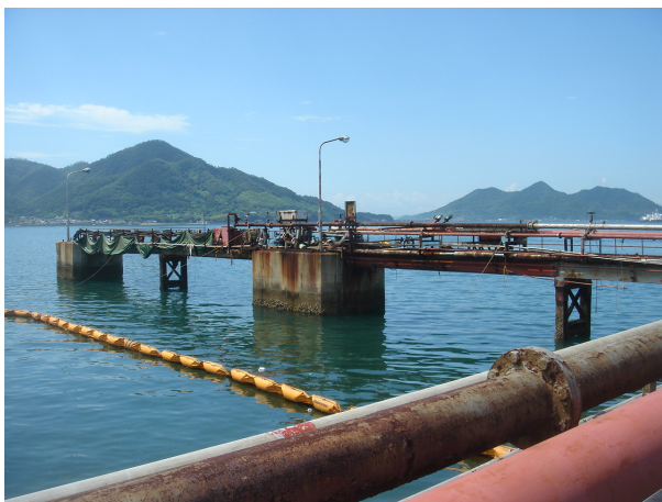
写真-1 既設栈橋状況
