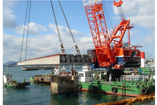
写真-2 主桁架設状況
