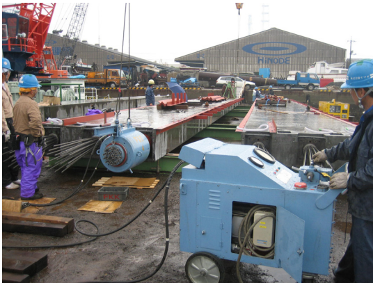
写真-5 緊張作業状況
