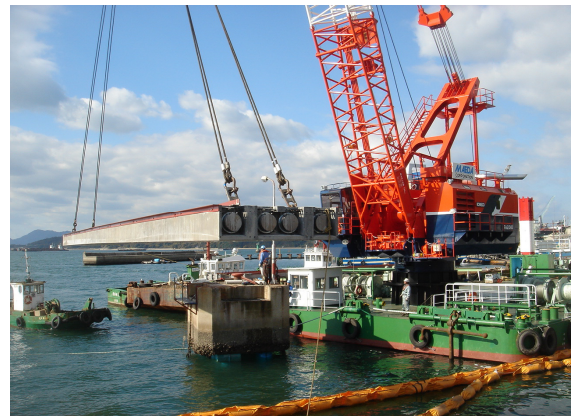
写真-6 主桁架設状況
