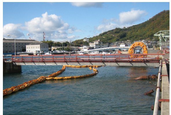
写真-8 完成状況
