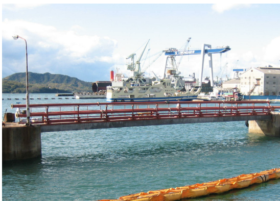
写真-7 完成状況
