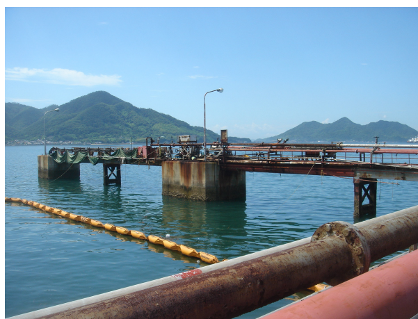
写真-1 既設栈橋状況
