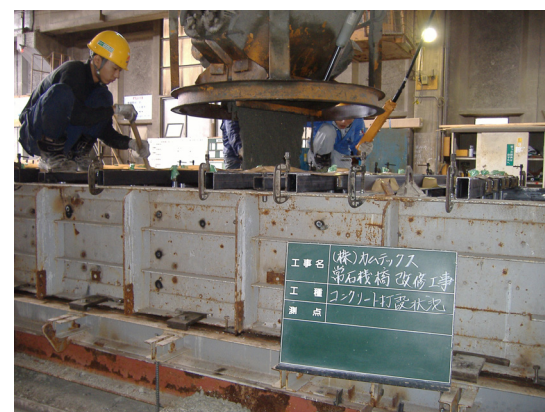
写真-4 打設状況
