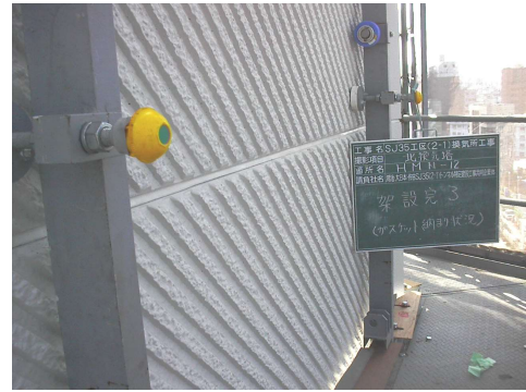
写真-3 プレキャスト部材据付 (ブラケット足場)
