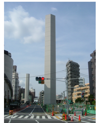
写真-5 換気塔全景
