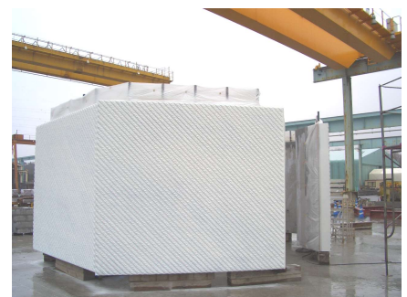
写真-2 プレキャスト部材(光触媒塗装)
