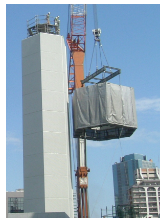
写真-4 架設状況
