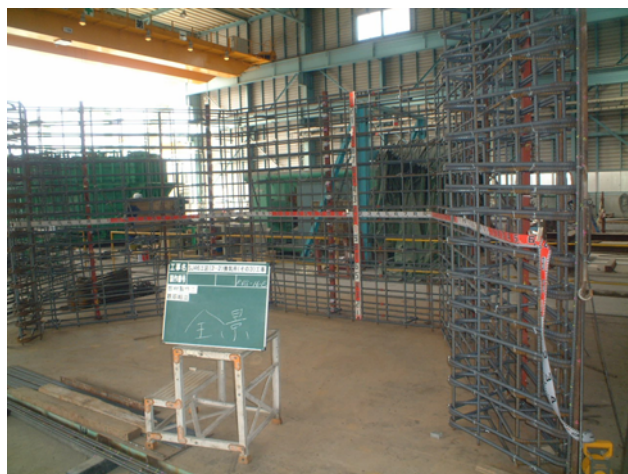
写真-1 鉄筋組立
