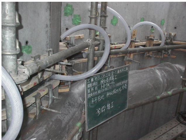
写真-24 目地型枠組立状況
