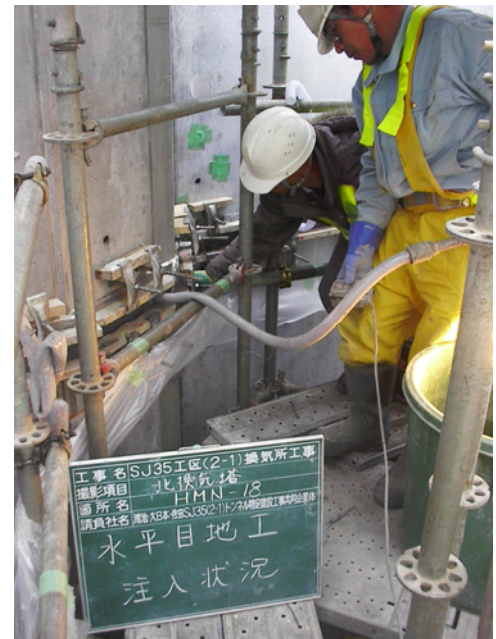
写真-25 無収縮充填状況
