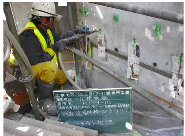
写真-28 鉛直鋼棒グラウト
