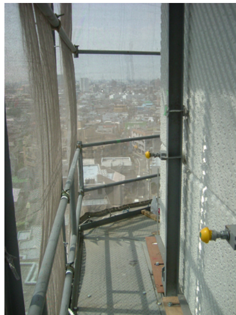
写真-18 足場防護内側
