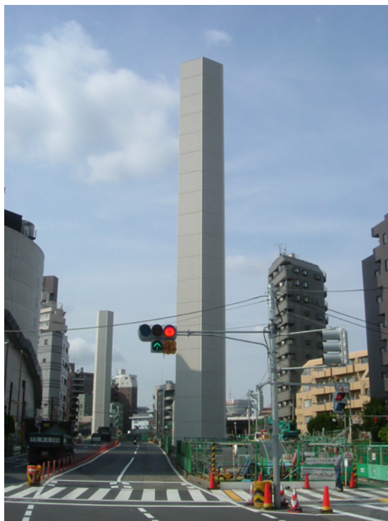
写真-29 換気塔全景
