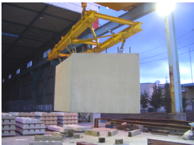
写真-7 吊り込み状況
