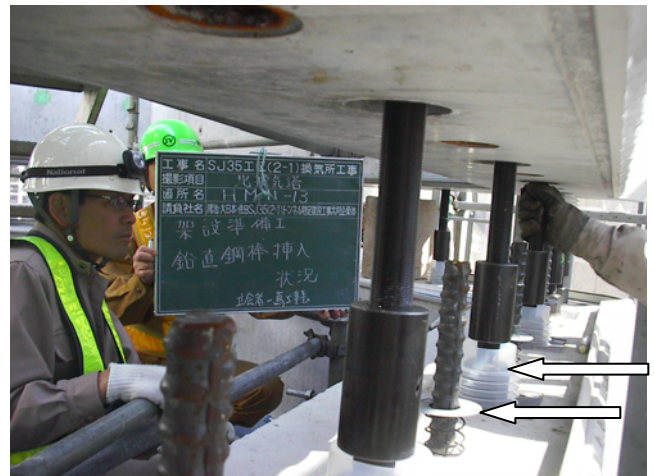
写真-22 PC鋼棒接続状況 モルタル進入防止治具 ( ← )
