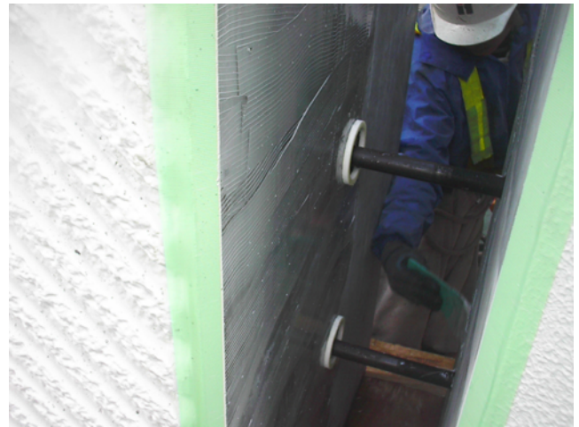
写真-14 PC鋼棒接続、 接着剤塗布
