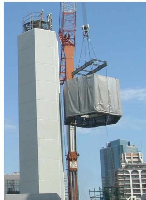
写真-12 プレキャスト部材 架設 (吊り治具使用)
