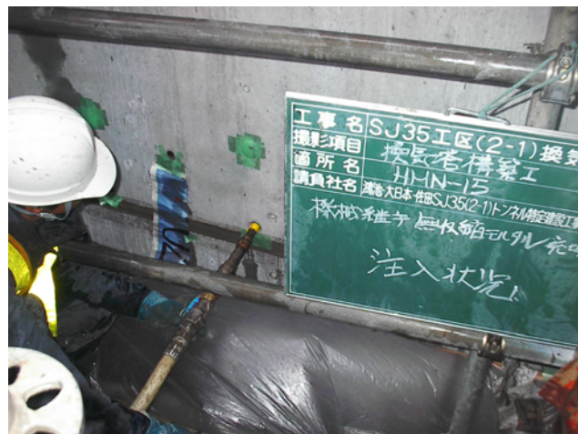
写真-26 無収縮充填状況
