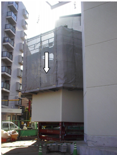
写真-17 ブラケット足場設置 矢印方向へ降下
