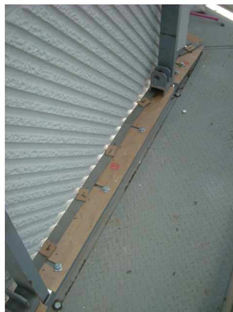
写真-20 部材と足場の隙間養生
