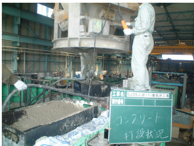
写真-5 コンクリート打設
