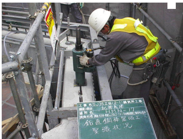
写真-27 鉛直鋼棒緊張
