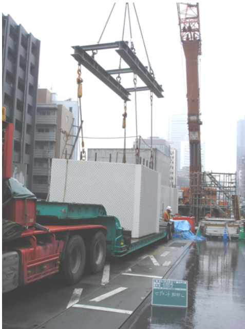
写真-11 プレキャスト部材 取り卸し (吊り治具使用)
