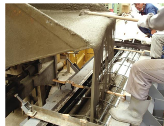
写真-4 打込み状況
