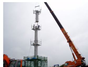
写真-6 建込み状況
