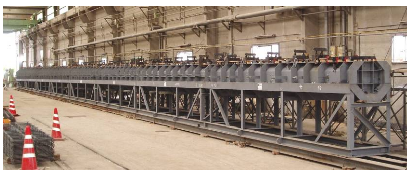
写真-4 型枠全景
