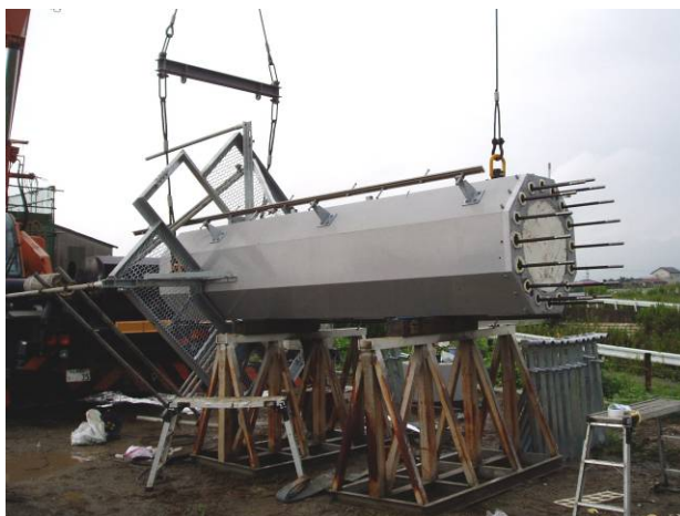
写真-13 セグメント仮置き
