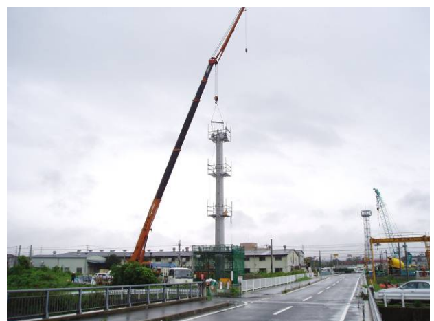
写真-20 No.4ブロック建込み
