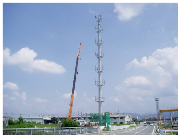
写真-22 No.8ブロック建込み
