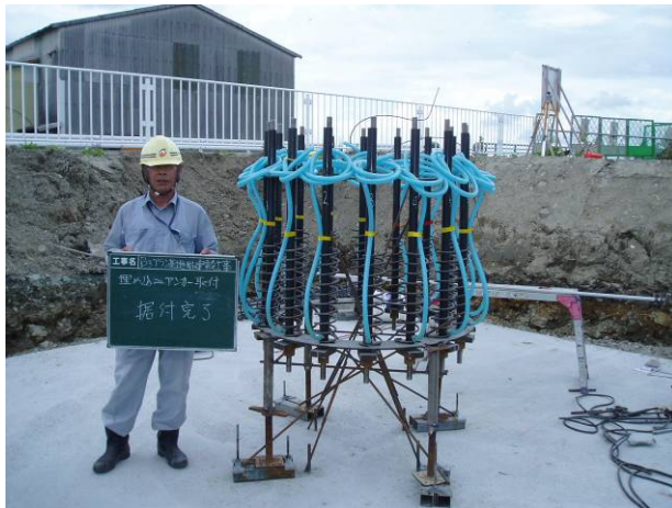
写真-11 アンカー設置
