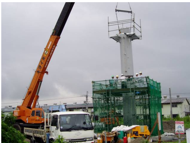
写真-17 No.2ブロック建込
