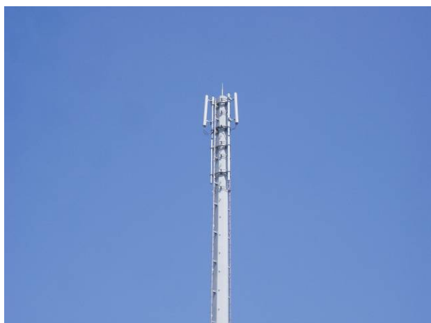
写真-23 付属物など取付け
