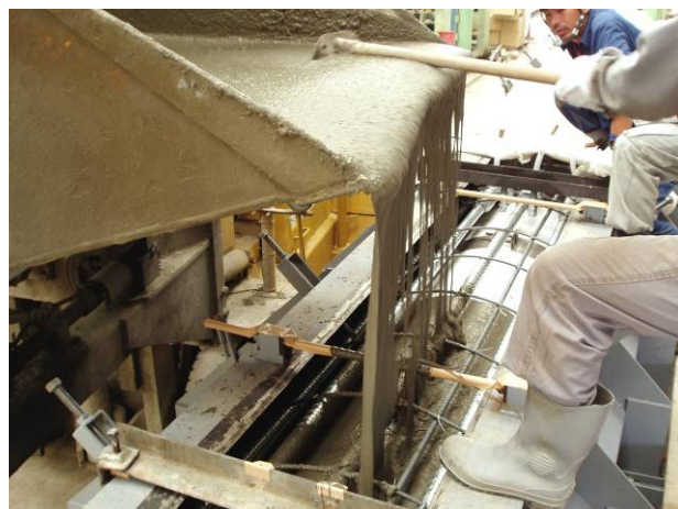
写真-6 打込み状況
