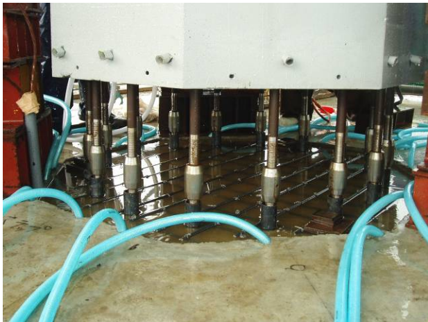
写真-15 PC鋼棒接続 (基部)
