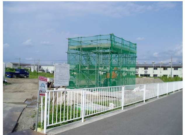
写真-12 枠組足場組立
