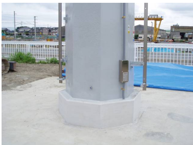
写真-24 根巻きコンクリート
