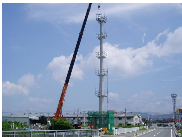
写真-21 No.6ブロック建込み
