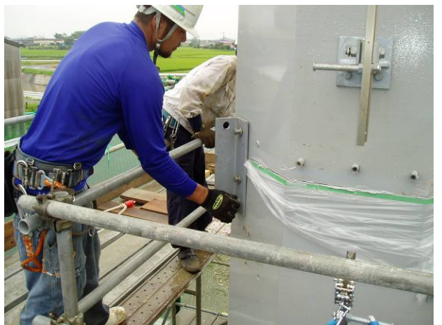
写真-18 仮留めプレート取付け
