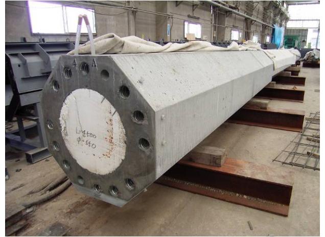
写真-8 脱枠状況
