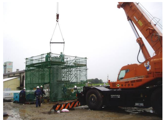
写真-14 No.1ブロック建込み
