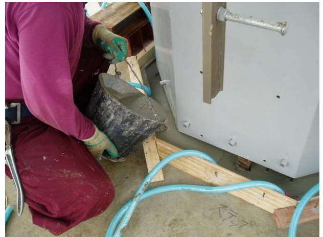
写真-16 無収縮モルタル打設 (基部)
