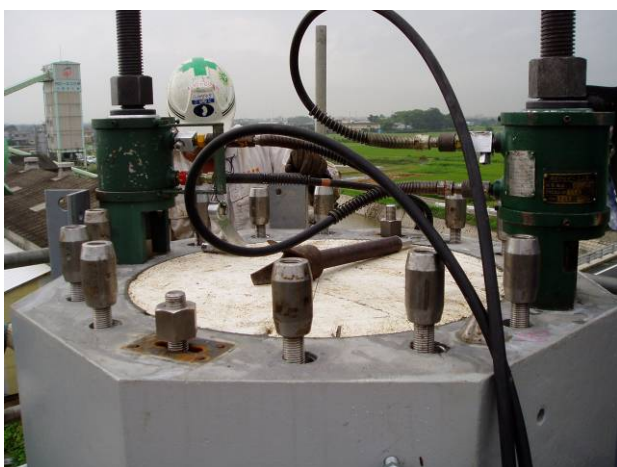
写真-19 PC鋼棒緊張
