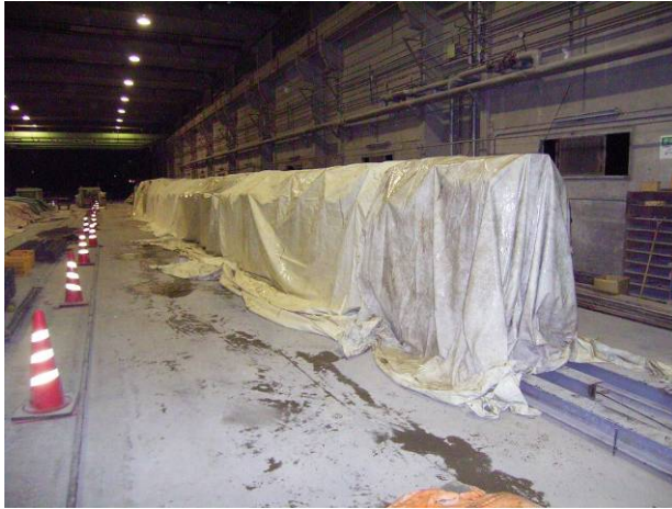
写真-7 養生状況
