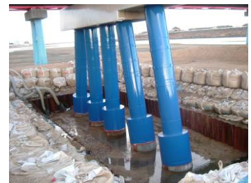
写真-4 完成状況
