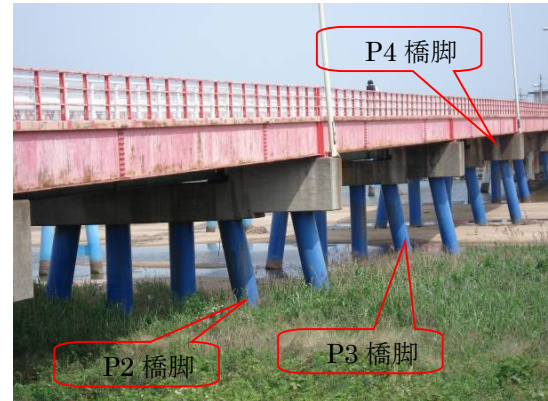
写真-1 着工前状況
