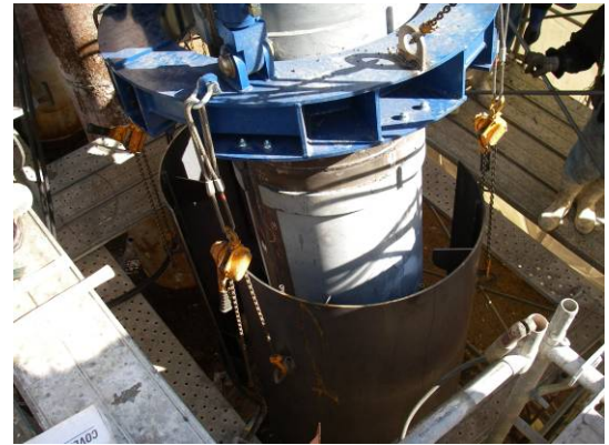
写真-5 補強鋼板
