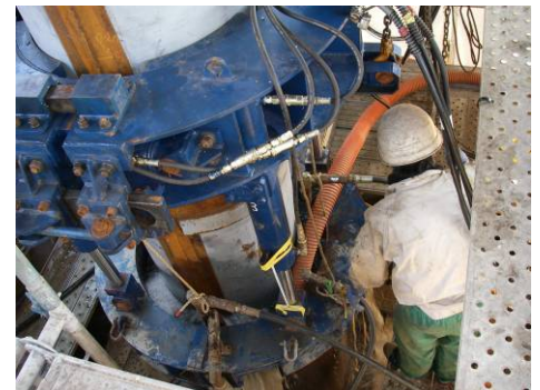
写真-6 圧入状況
