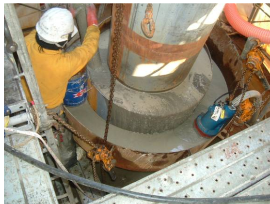
写真-9 コンクリート充填
