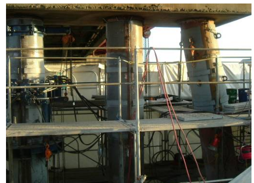
写真-3 反力用鋼板
