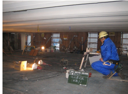
写真-3 仮通電試験状況
