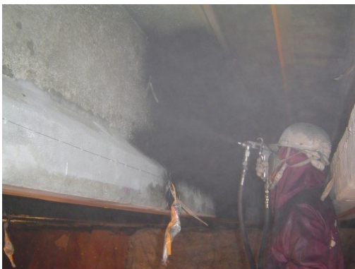
写真-2 二次陽極吹付け状況
