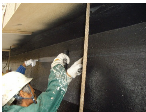
写真-9 ビニロンメッシュの貼付け状況
