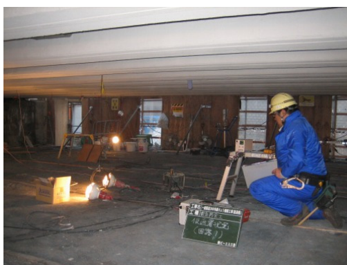
写真-12 仮通電試験状況
