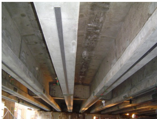
写真-5 炭素繊維プレートの設置状況
