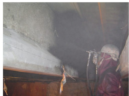
写真-8 二次陽極の吹付け状況
