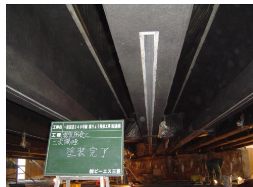
写真-6 炭素繊維プレートの施工状況
