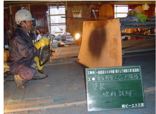
写真-10 試験吹き状況
