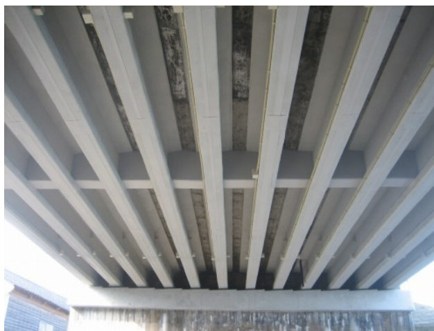
写真-14 完成状況
