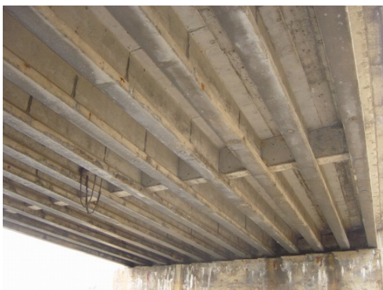
写真-1 主桁全景
