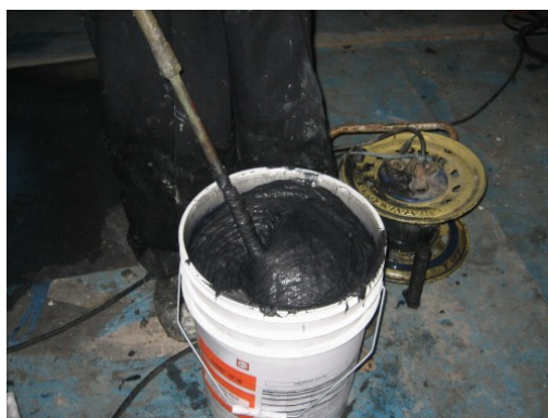
写真-7 二次陽極の攪拌状況
