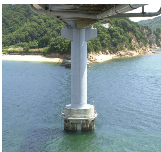
写真-2 P2 橋脚 (施工前)
