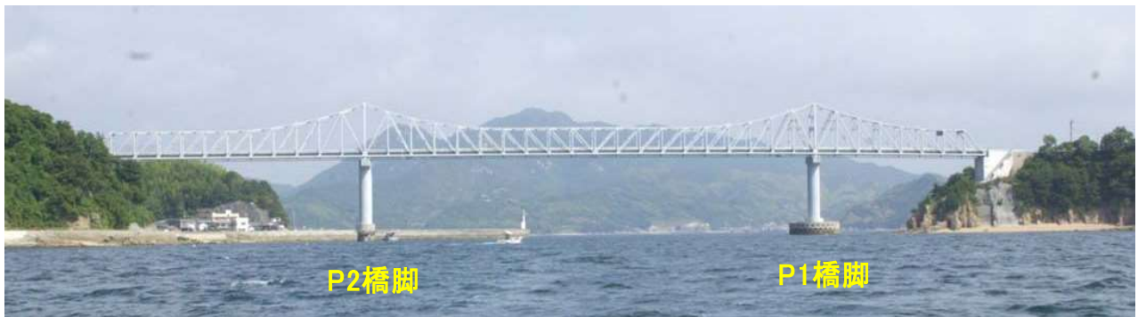
写真-1 橋梁全景 (施工前)
