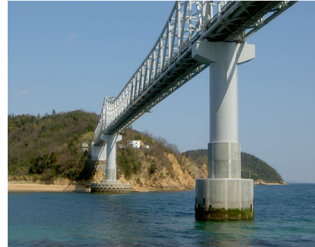
写真-4 P2橋脚(施工後)
