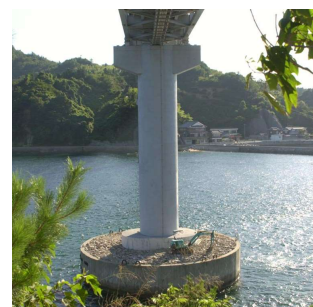
写真-3 P1 橋脚 (施工前)
