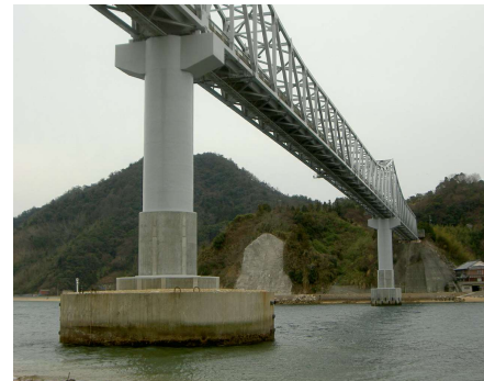
写真-5 P1橋脚(施工後)
