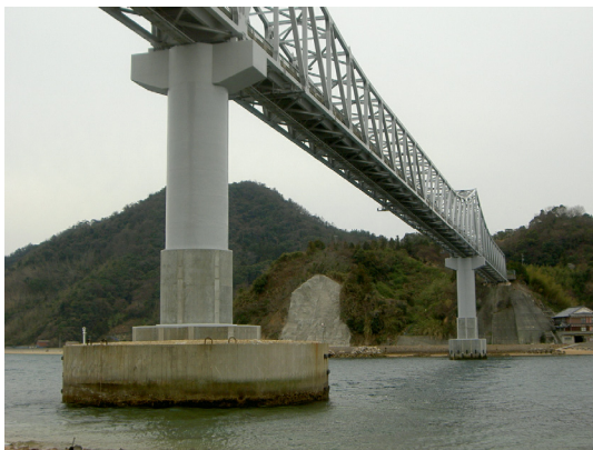
写真-4 P1 橋脚(施工後)
