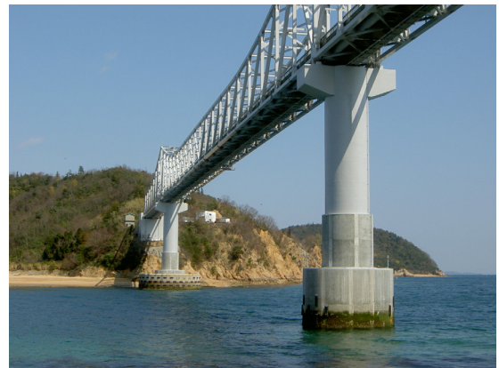
写真-5 P2 橋脚(施工後)
