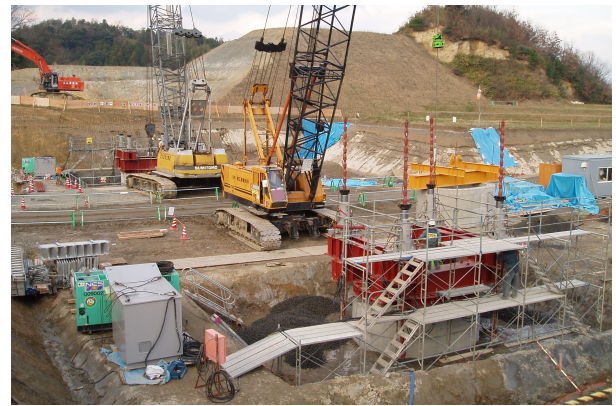
写真-2 PPRCウェル圧入状況
