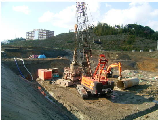
写真-1 先行掘削状況
