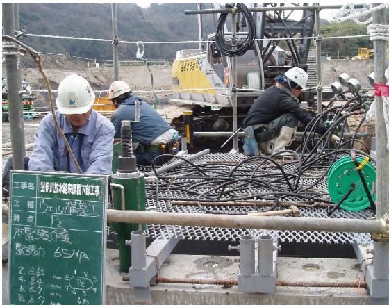
写真-14 PC鋼棒緊張状況
