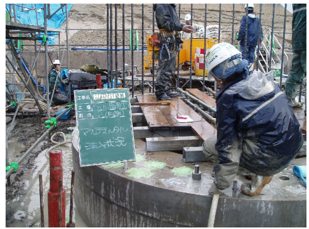
写真-19 マルチモルタル注入状況
