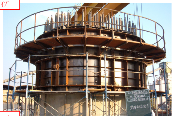
写真-4 型枠組立状況
