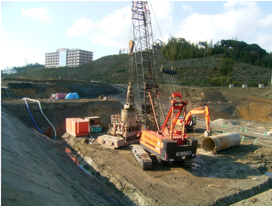
写真-1 先行掘削状況
