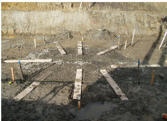
写真-11 刃口ロット皿板材設置状況
