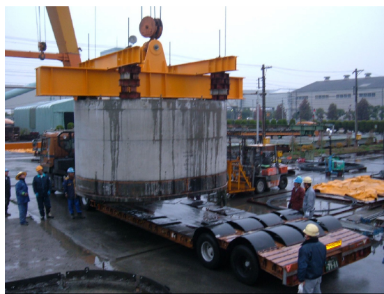
写真-7 PPRCウエル積み込み状況
