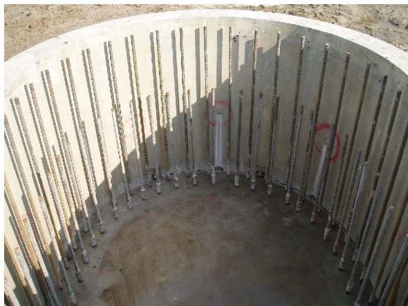
写真-20 PPRCウェル圧入完了（頂版施工前）
