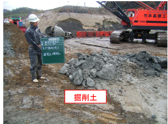
写真-2 掘削土状況（軟岩）
