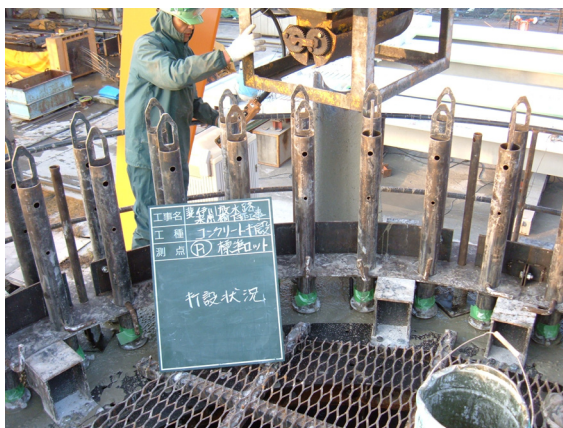
写真-5 コンクリート打設状況
