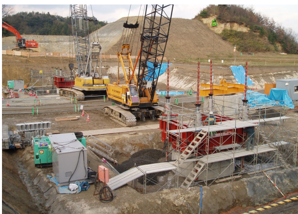
写真-16 PPRCウェル圧入状況
