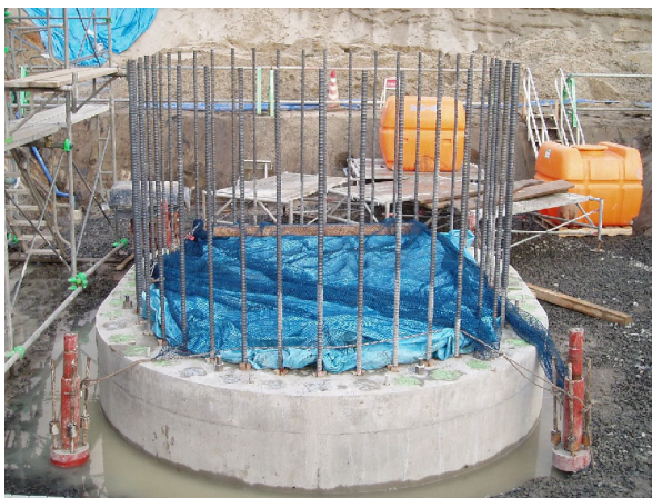
写真-18 軸方向鉄筋挿入状況
