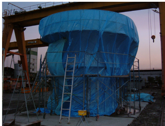
写真-6 養生状況
