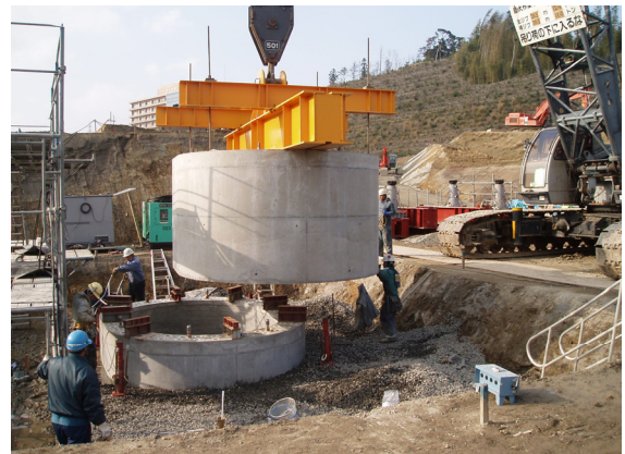
写真-12 PPRCウエル架設状況
