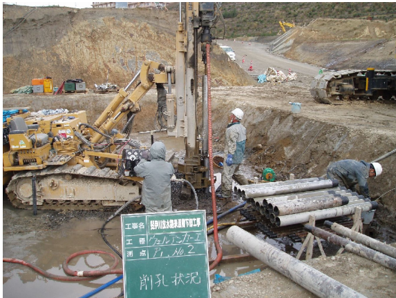
写真-9 グラウンドアンカー施工状況
