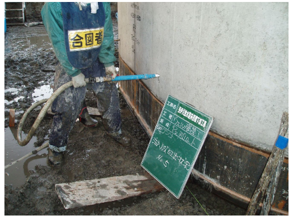
写真-15 グラウト注入状況
