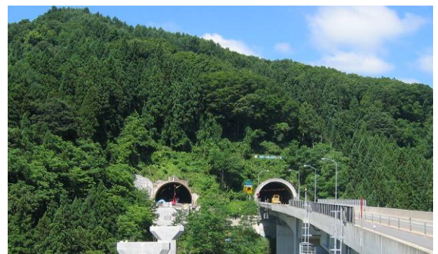
写真-3 長野側(貫通側)坑口を望む
