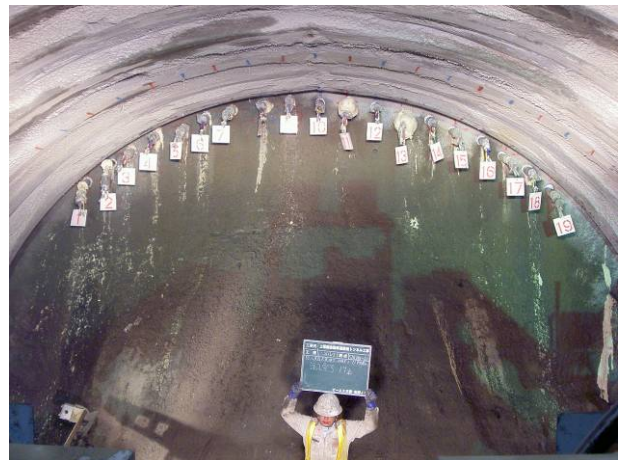
写真－7 低土被り部の AGF 工法(90°)
