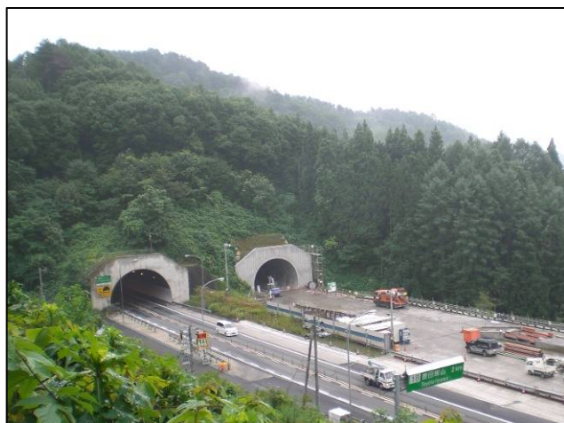
写真-8 新潟県側坑口を望む
