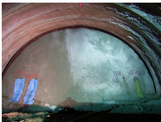
写真-4 水抜きボーリング
