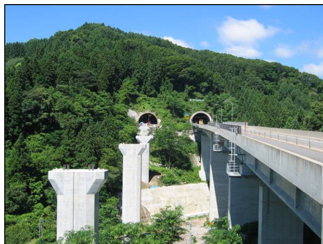
写真-9 長野側（貫通側）坑口を望む
