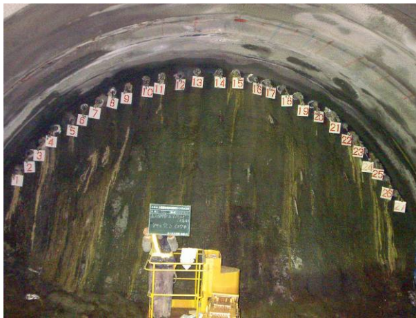
写真－6 通常(坑口区間施工)の AGF 工法(120°)
