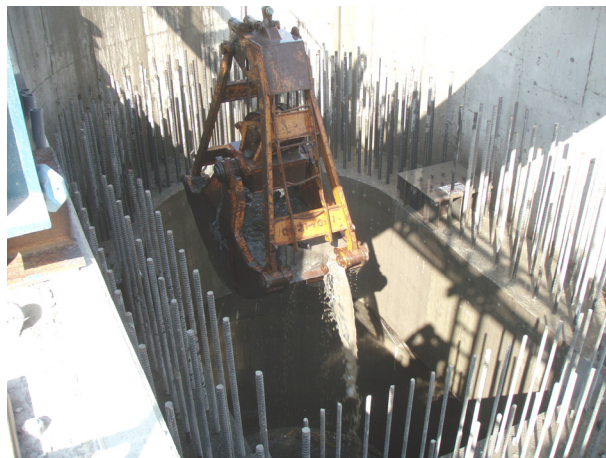
写真-7 圧入掘削状況 (昼方)
