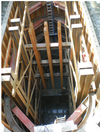
写真-10 圧入架台設置状況
