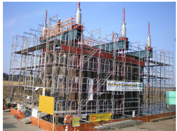
写真-11 鋼製止水壁・圧入架台設置完了
