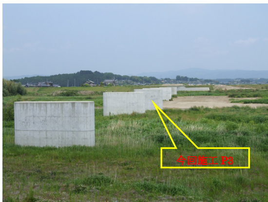
写真-1 下部工全景
