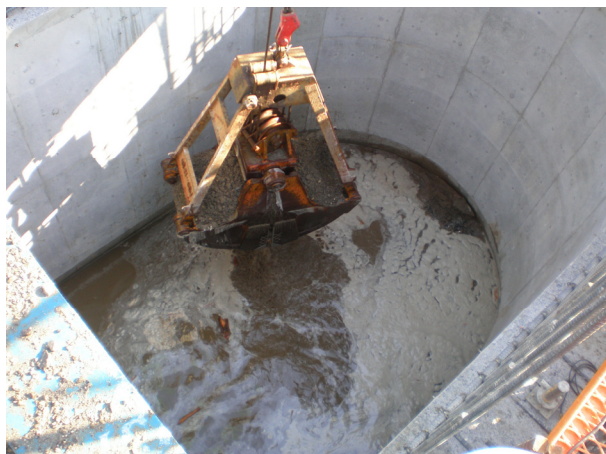
写真-8 圧入掘削状況 (昼方)
