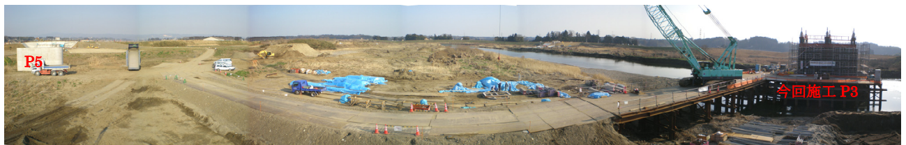
写真-3 P3 工事施工状況 (P4 より撮影, 平成 19 年 2 月末撮影)
