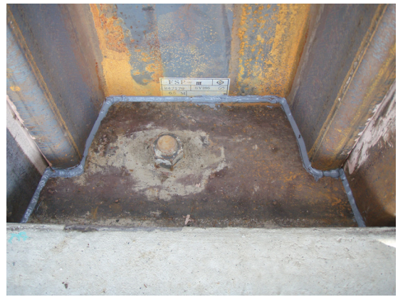
写真-13 ボンドリング完了
