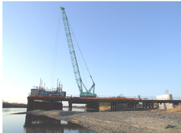
写真-5 圧入掘削状況 (昼方)
