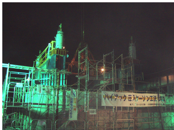
写真-9 圧入掘削状況 (夜方)
