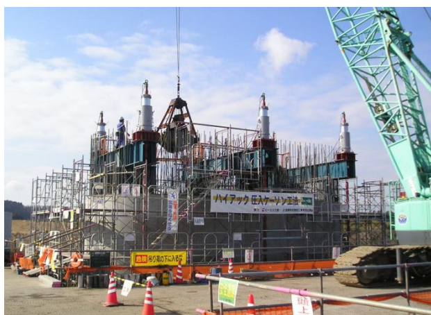
写真-6 圧入掘削状況 (昼方)
