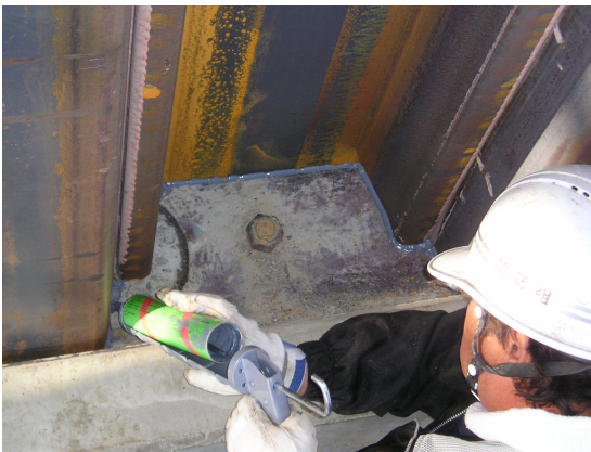
写真-12 ボンドリング施工状況
