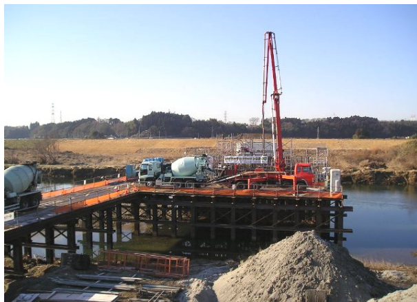
写真-4 ケーソンコンクリート打設状況
