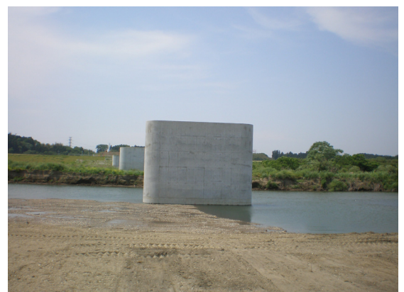
写真-2 P3 橋脚完成
