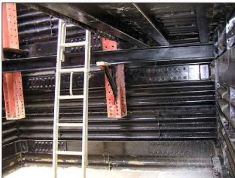
写真-20 拡幅立坑全景
