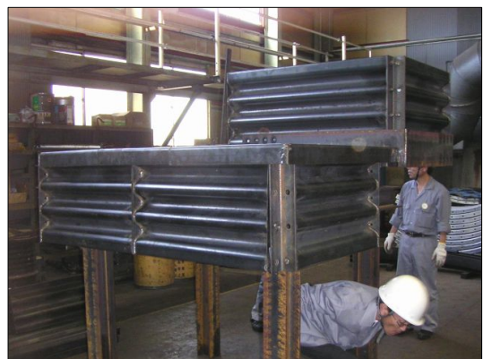
写真-1 拡幅部工場組立状況
