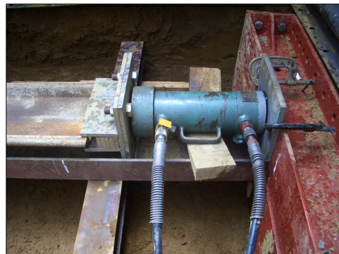
写真-9 挿入冶具使用状況
