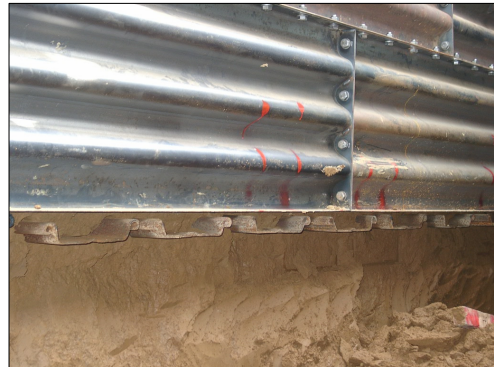
写真-11 矢板圧入完了
