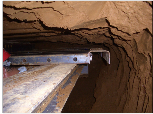
写真-17 天井ライナー設置
