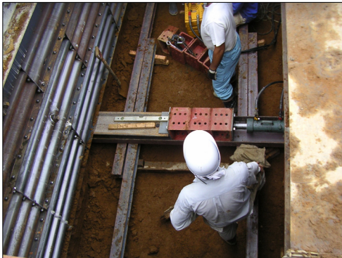
写真-10 圧入状況
