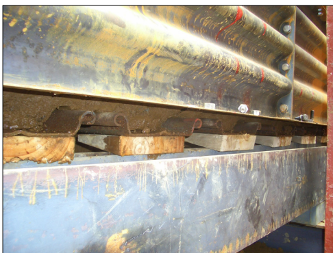
写真-14 仮屋根固定
