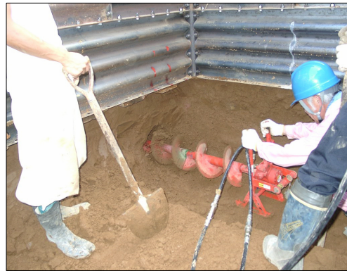
写真-12 削孔状況
