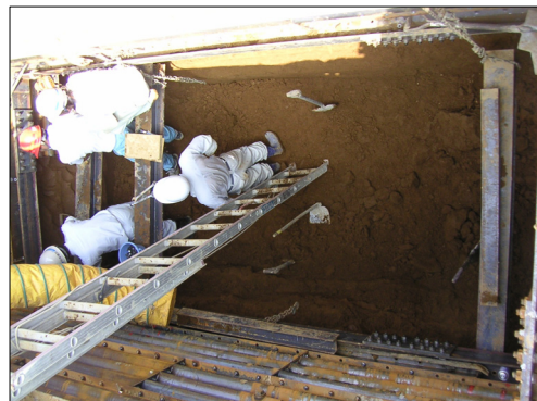
写真-13 受桁設置状況
