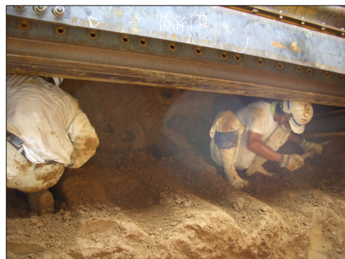
写真-14 仮屋根固定
