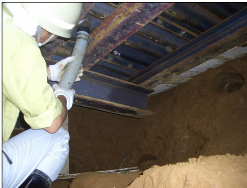
写真-18 天井グラウト注入
