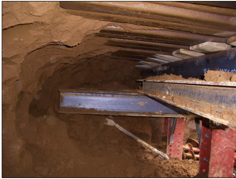
写真-16 拡幅部掘削状況
