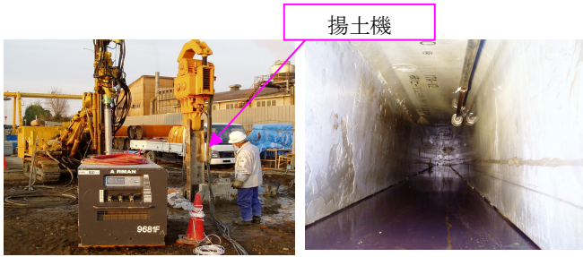
写真-2 掘削状況
