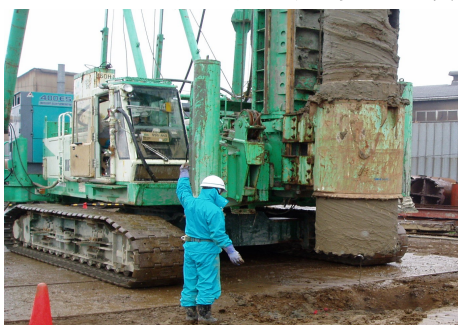
写真-1 二軸同軸式アースオーガによる先行掘削状況
