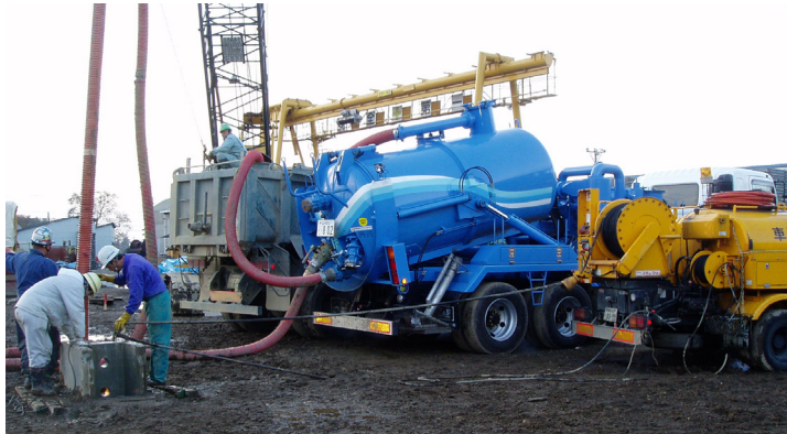
写真-5 壁面の清掃状況
