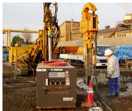
写真-3 H型鋼掘削機による掘削状況
