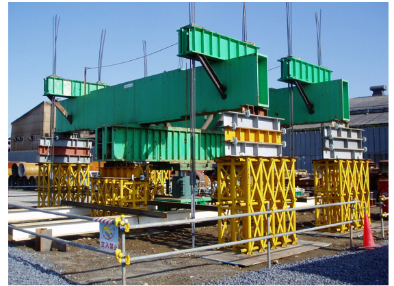
写真-7 鉛直載荷試験状況
