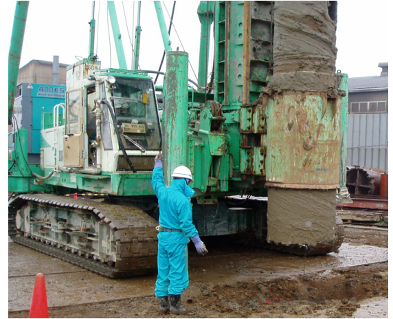
写真-1 二軸同軸式アースオーガによる先行掘削状況
