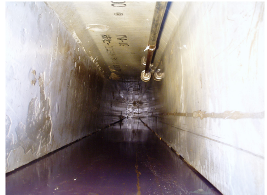
写真-6 壁面の清掃完了
