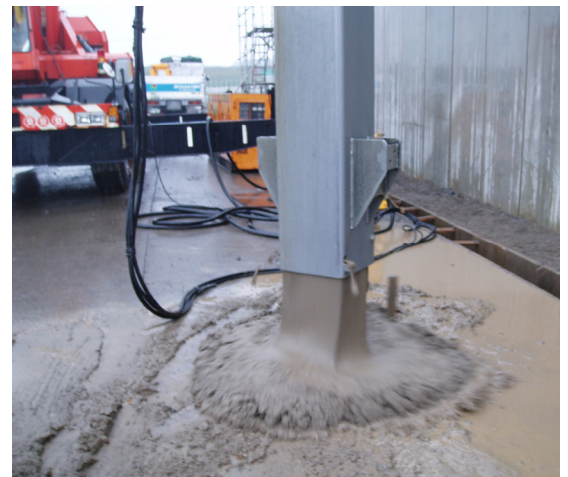
写真-2 特殊掘削機による掘削状況
