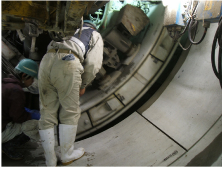
写真-8 セグメントの把持・移動 セグメントをエレクターにて把持し、所定の位置まで旋回・移動する。
