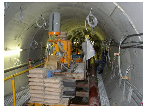
写真-24 坑内作業状況
