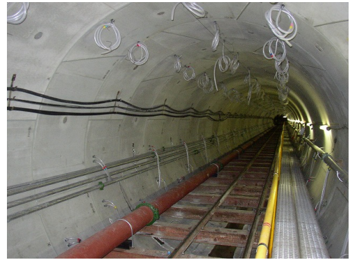
写真-21 グラウト注入前
