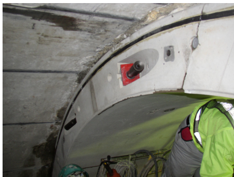
写真-14 Kセグメント組立前 既にカップラーは取り付けられている状況。
