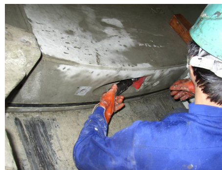
写真-7 カップラー取付け 既設の PC 鋼材緊張端に接続用カップラーを取り付けている状況。
