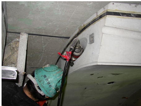
写真-12 緊張状況 同時に二本の PC 鋼材を緊張した。
