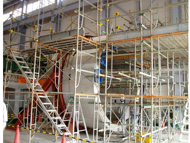
写真-4 鉛直仮組試験
