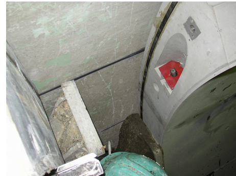
写真-11 挿入・接続完了 グリップの突出量にてカップラーへの接続状況の確認を行った。
