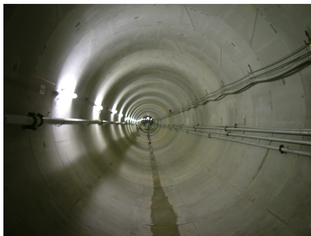
写真-1 施工完了状況
