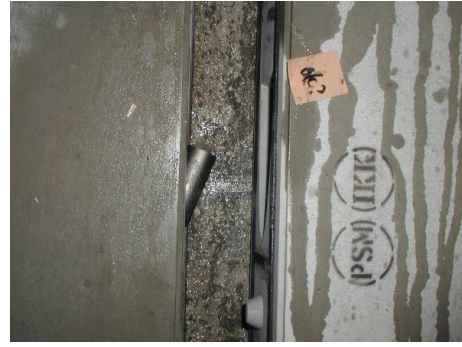
写真-9 カップラー，調芯ピン 左が既設，右が新設側。カップラーと調芯ピンが確認できる。
