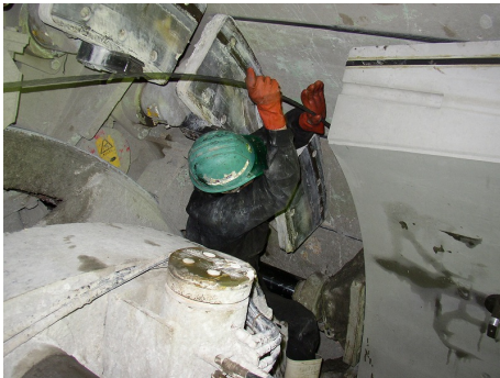
写真-10 PC 鋼材挿入状況 PC 鋼材は人力にて一本ずつ挿入した。
