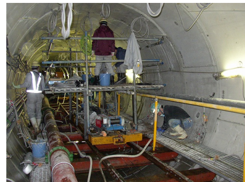
写真-22 作業足場台車
