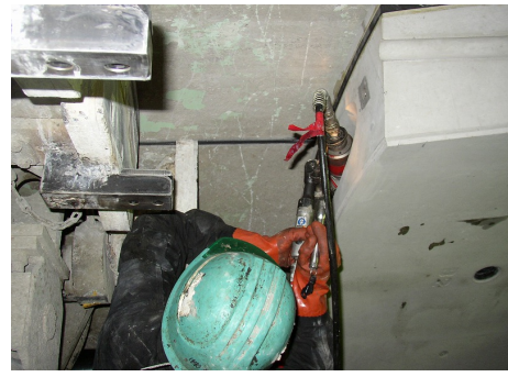
写真-13 定着作業 所定の緊張力が導入された後、エアラチェットにてナットを締め付けた。
