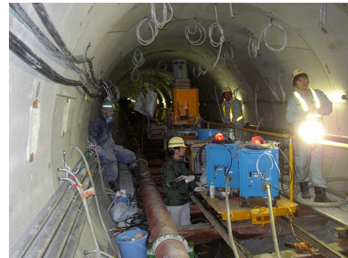
写真-23 坑内作業状況
