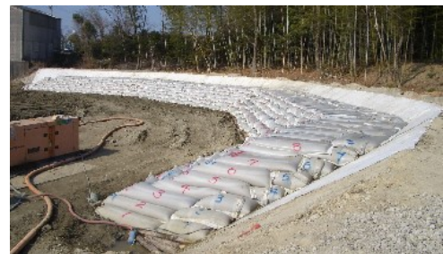
写真-3 施工完了直後状況
