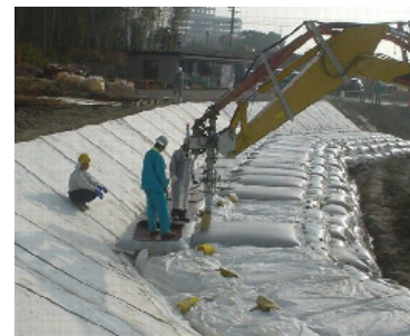
写真－2 施工状況
