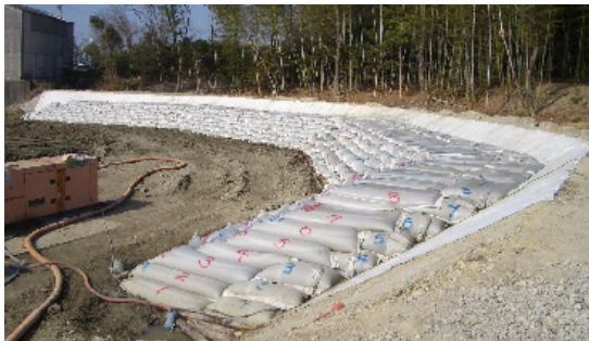
写真-4 施工完了直後
