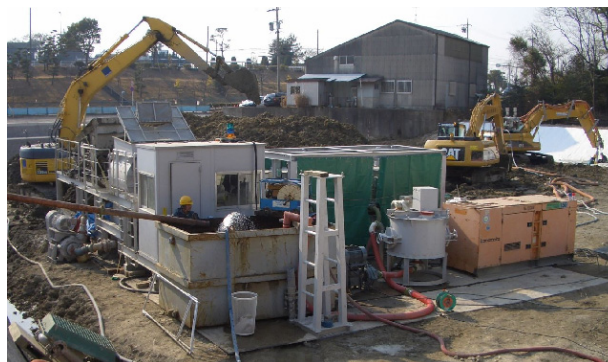
写真－3 施工システム全景
