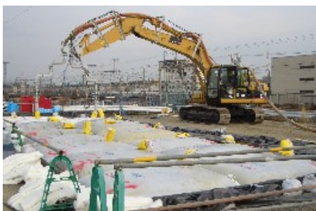
写真-4 充填・脱水仮置き場全景
