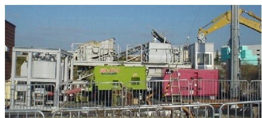
写真-1 施工システム全景
