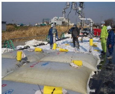
写真-3 充填状況
