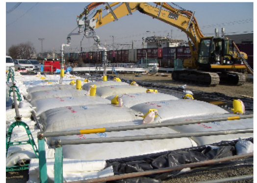
写真－8 充填・脱水ヤード
