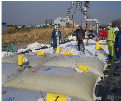
写真-5 施工状況
