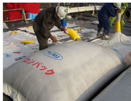
写真-6 袋材充填時状況
