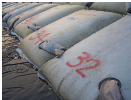
写真-12 脱水排水状況
