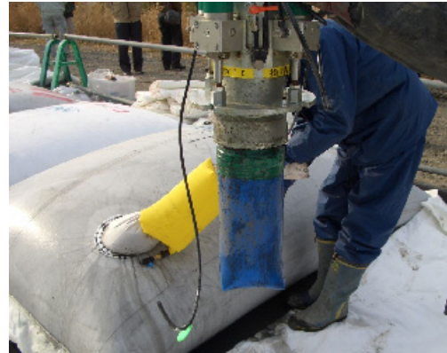
写真－11 充填口施工状況
