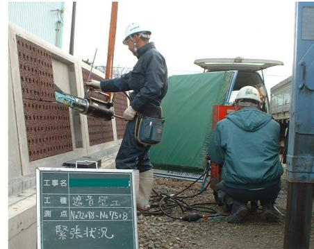
写真-3 PC鋼材緊張状況
