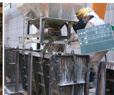
写真-4 防護柵製作
