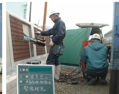
写真-8 PC鋼材緊張
