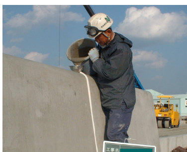
写真-7 目地モルタル注入
