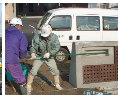
写真-6 PC鋼材挿入
