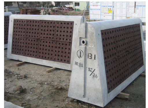
写真-1 低層遮音壁
