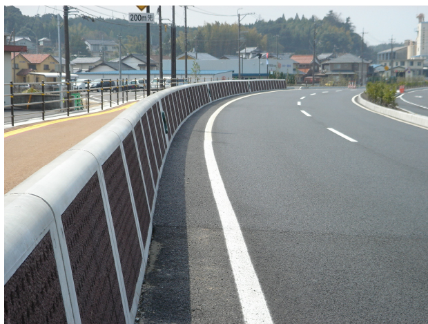
写真-9 完成後 (106m 部)
