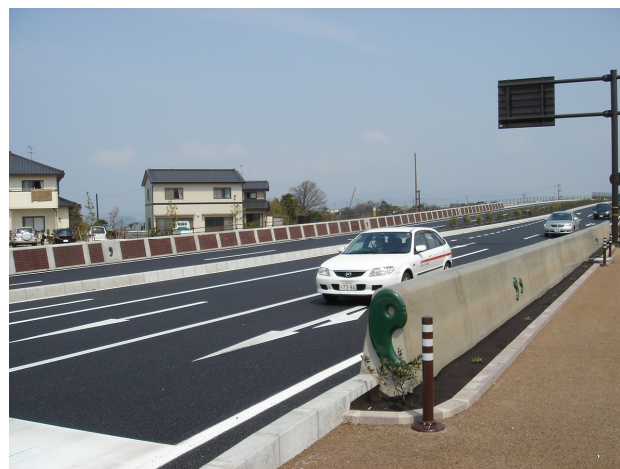
写真-10 完成後 (104m 部, 32m 部)
