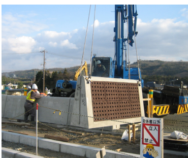
写真-5 部材据付
