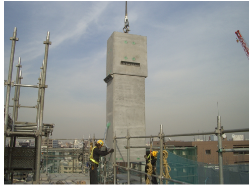
写真-4 柱建て方状況
