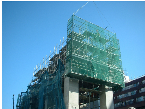
写真-3 せり上げ状況
