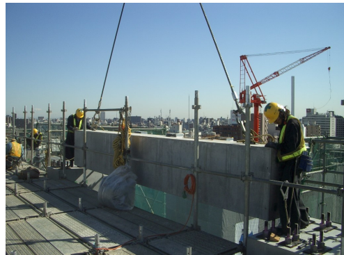
写真-5 梁架設状況
