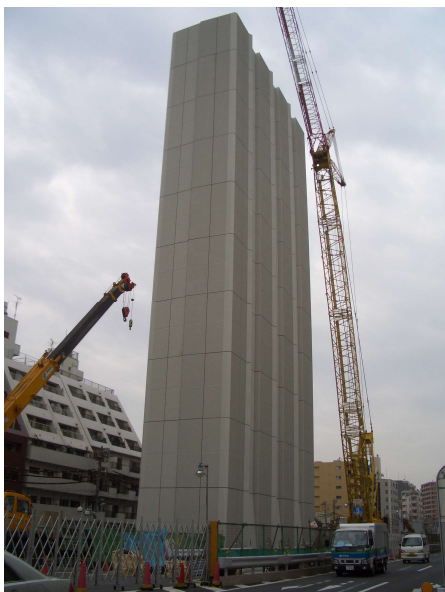
写真-1 建物外観
