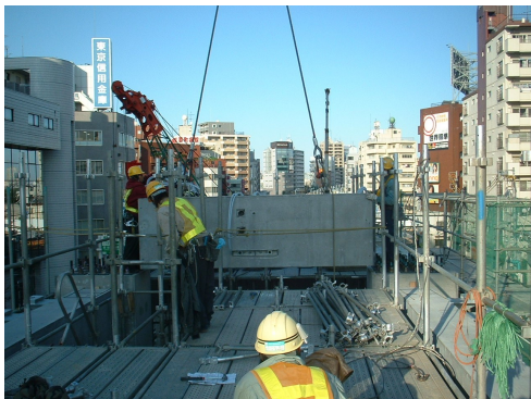
写真-2 内部足場
