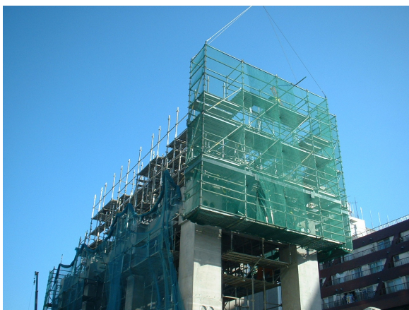
写真-3 連層システム足場せり上げ状況
