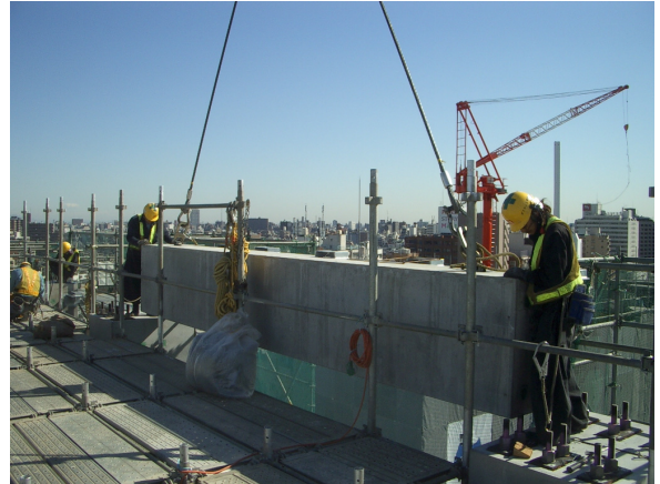
写真-6 梁架設状況
