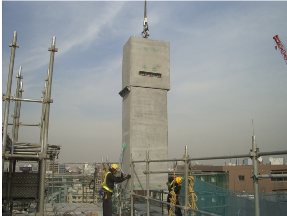
写真-5 柱建て方状況
