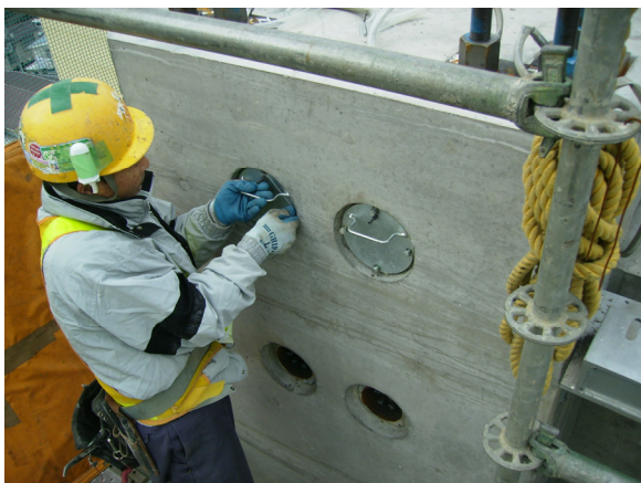
写真-9 PC鋼より線緊張状況
