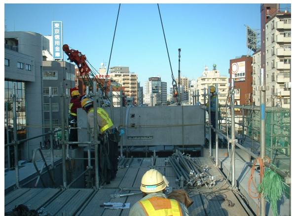
写真-2 内部足場
