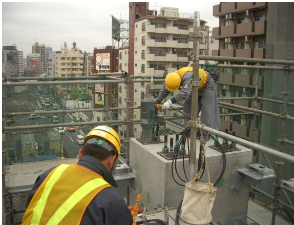
写真-7 柱PC鋼棒の緊張状況
