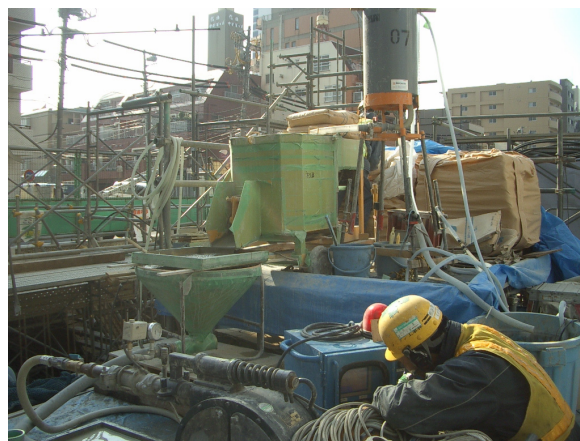
写真-14 グラウト練り場状況
