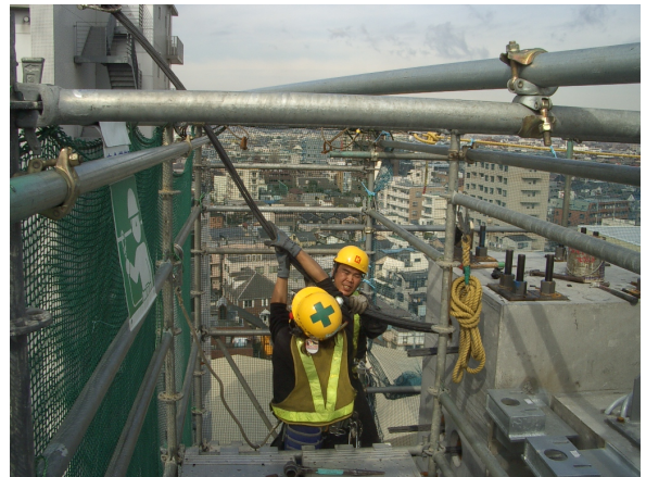
写真-8 PC鋼より線通線状況
