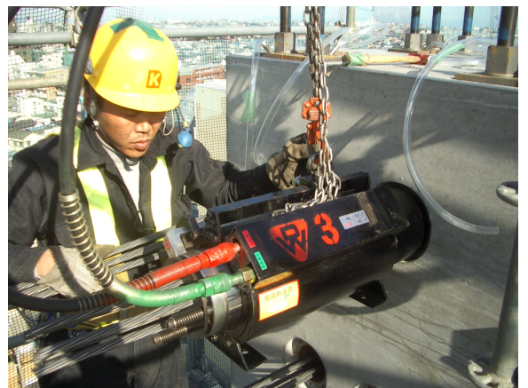
写真-10 グラウトプレート取付状況
