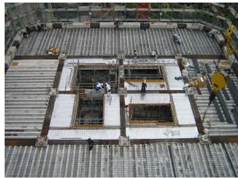
写真-2 PCa架設全景
