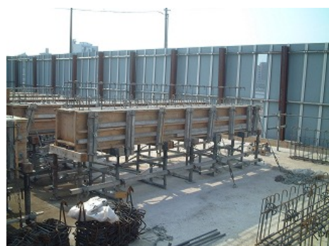
写真-5 サイトPCa小梁製作状況
