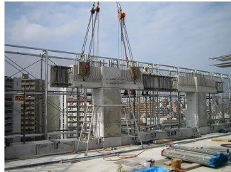
写真-3 柱梁一体部材架設状況
