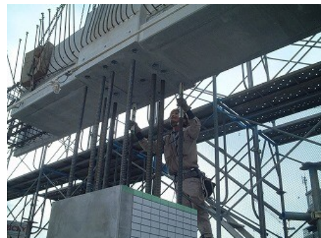
写真-4 柱梁一体部材鉄筋挿入状況
