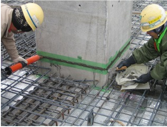
写真-14 モルタル型枠施工状況
