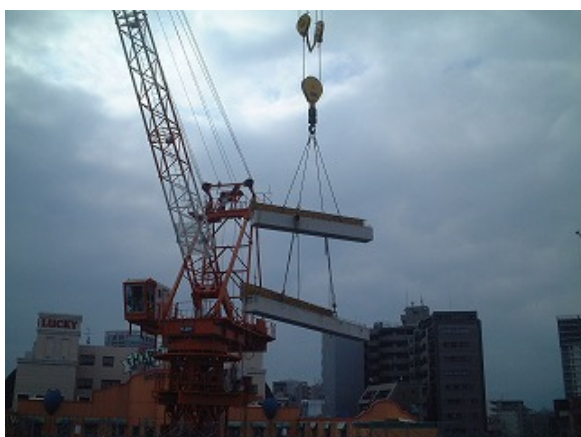
写真-8 小梁荷揚げ状況
