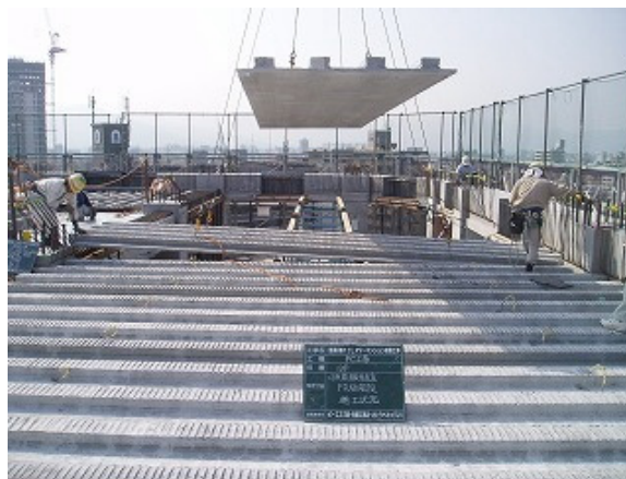
写真-11 PC床板荷揚げ状況
