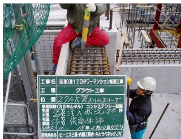
写真-20 大梁ジョイント部充填状況
