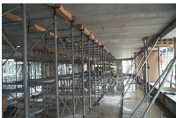
写真-12 PC床板中央部支保工状況
