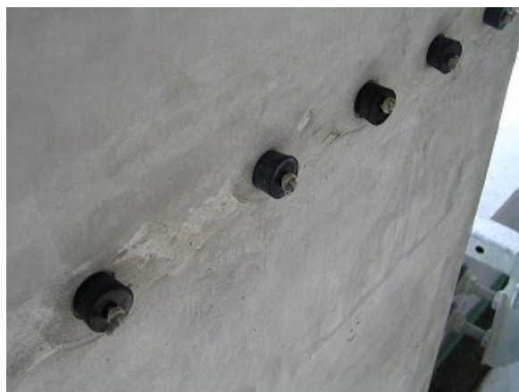
写真-18 充填前ゴム栓状況
