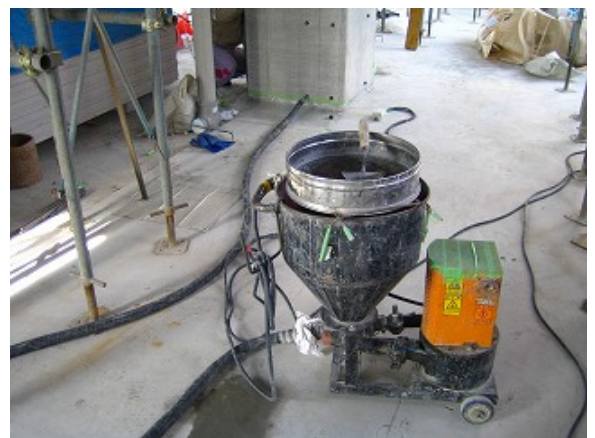
写真-17 柱脚部充填状況
