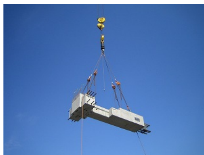
写真-4 梁部材タイプ毎の荷揚げ状況
