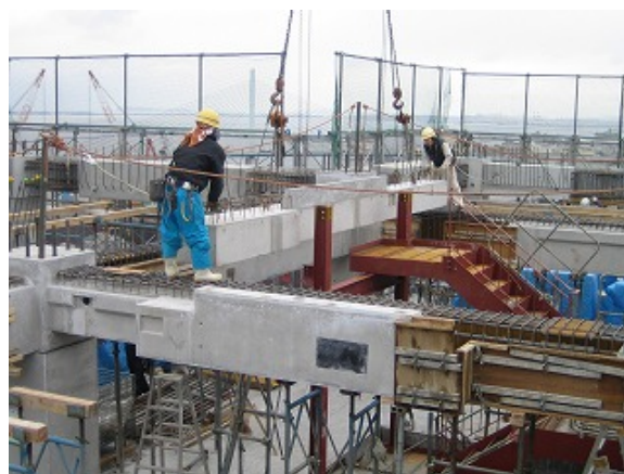
写真-9 小梁据付状況
