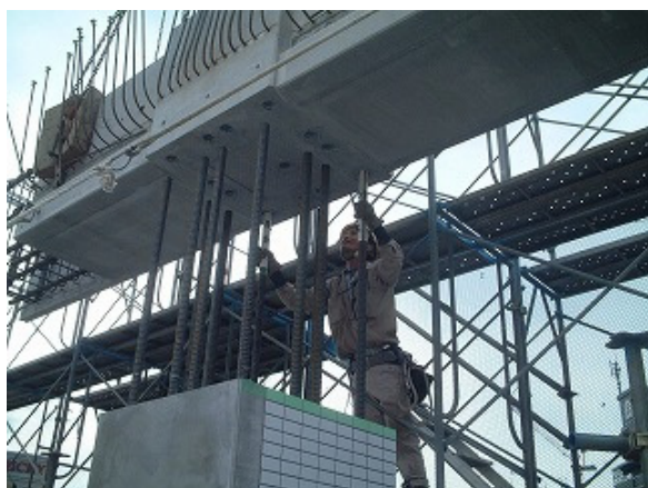
写真-5 主筋挿入状況
