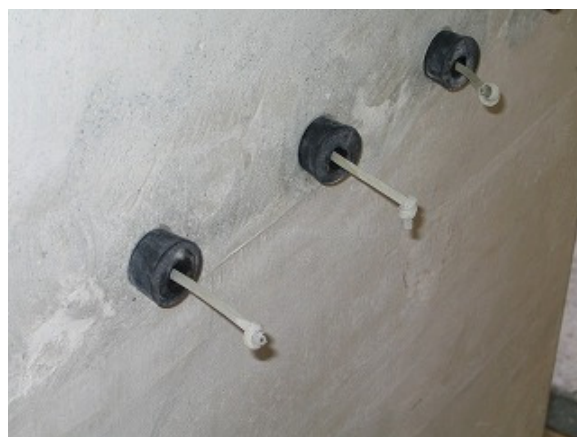
写真-19 充填後ゴム栓状況
