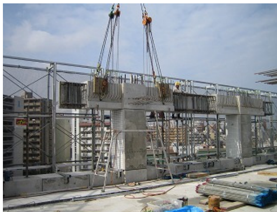
写真-6 レンコン梁据付
