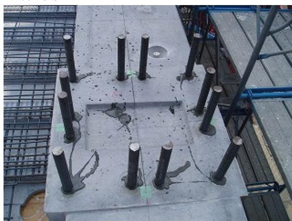
写真-22 パネルゾーン部充填完了
