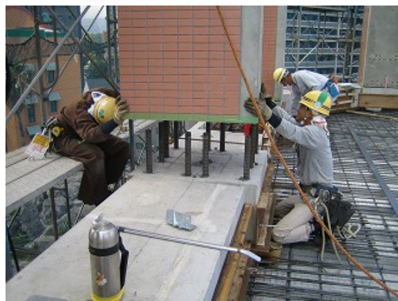
写真-3 柱据付状況
