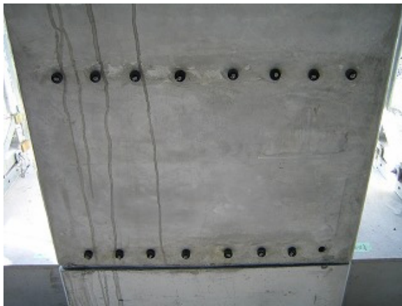
写真-16 柱脚部充填箇所
