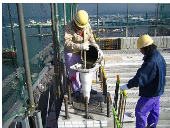
写真-21 パネルゾーン部充填状況
