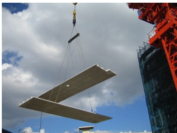
写真-10 PC床板荷揚げ状況
