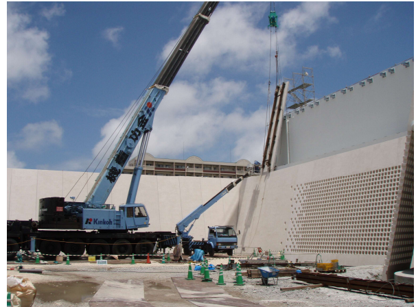
写真-4 架設状況
