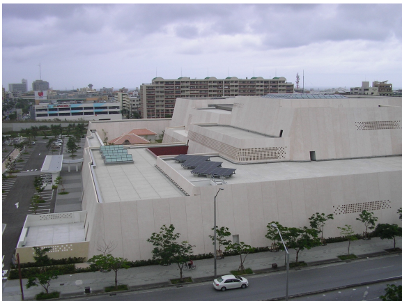
写真-2 建物全景
