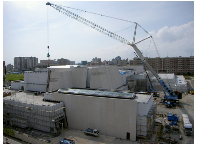
写真-21 架設状況
