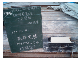
写真-13 バイブレーター無し
