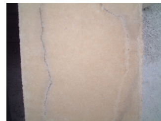
写真-15 バイブレーター痕跡
