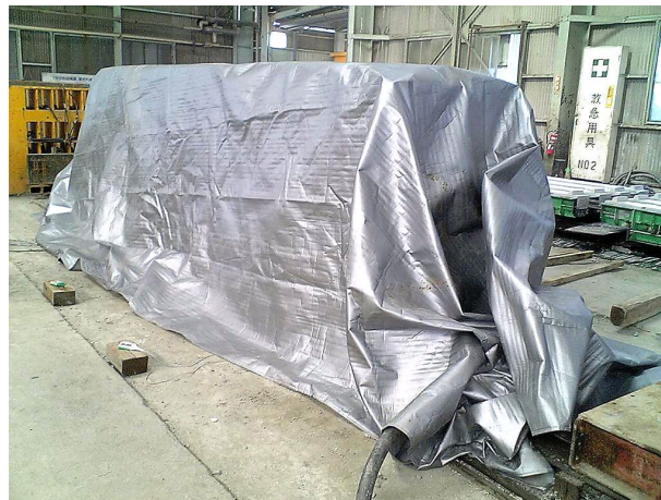
写真-1 蒸気養生状況
