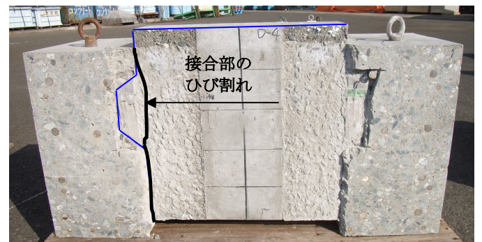
写真-2 ひび割れ状況 (C-S+UK)
