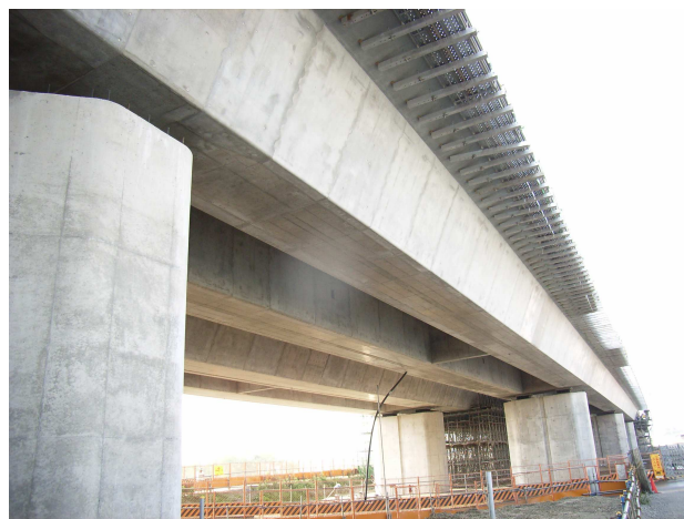
写真-1 中新田高架橋
