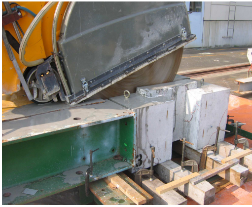
写真-3 床版部切断状況
