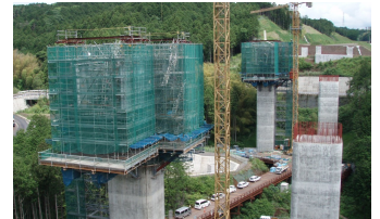
写真-1 平成20年6月施工状況
