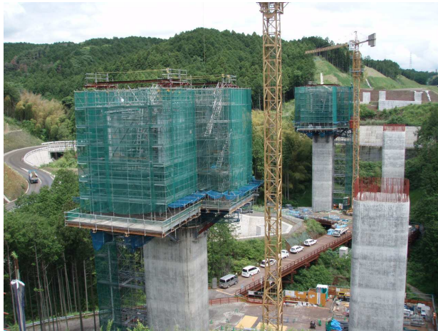
図-15 柱頭部ブラケット施工範囲 支保工範囲
