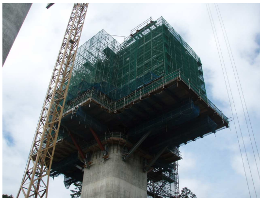
写真-3 柱頭部施工状況
