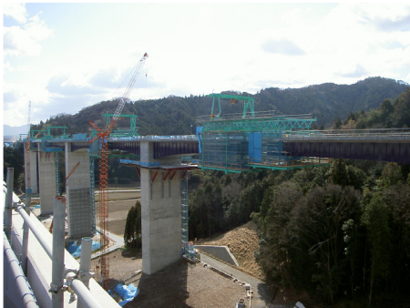
STEP-3 架設機移動・中央閉合部上床版打設
