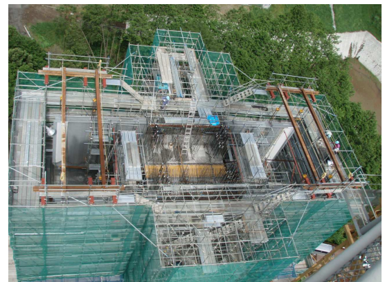
写真-3 柱頭部施工状況
