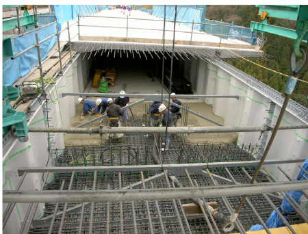
写真-5 中央閉合施工状況 (杉谷川橋)
