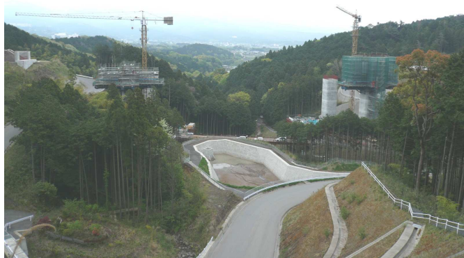
写真－6 平成 20 年 6 月施工状況
