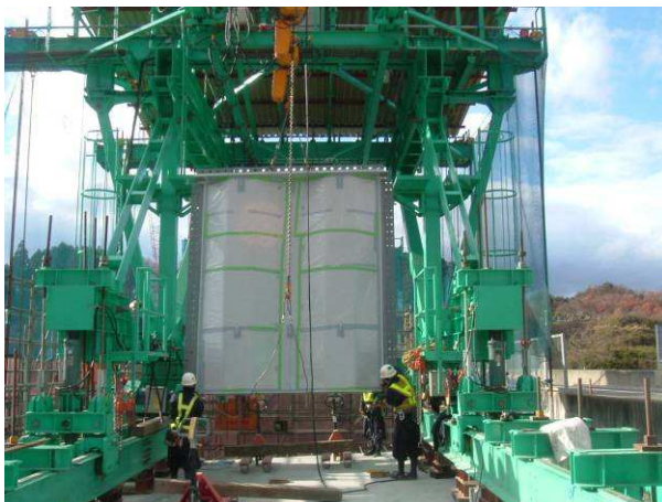
写真-13 波形ウェブ架設
