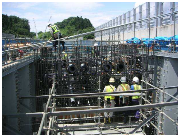
写真－11 柱頭部鉄筋組立
