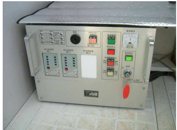
写真-7 LED式列車停止装置
