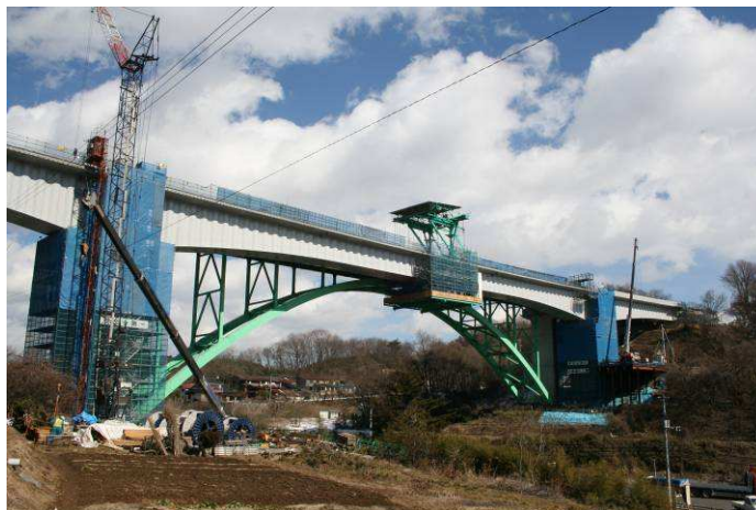
写真－1 施工写真
