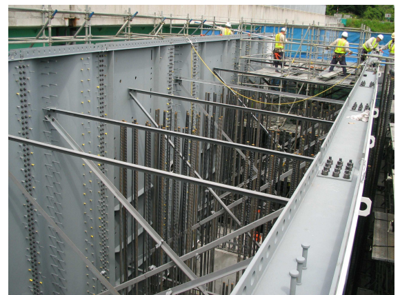
写真-4 波形ウェブ先行架設
