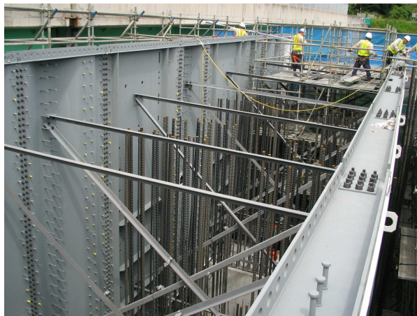
写真－9 波形鋼板先行架設
