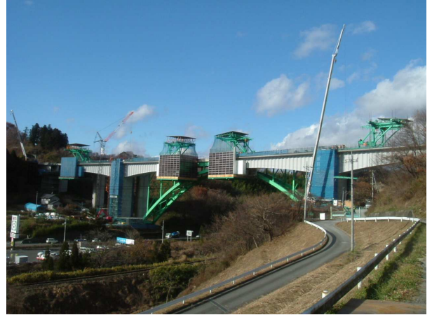
写真-12 張出し架設状況
