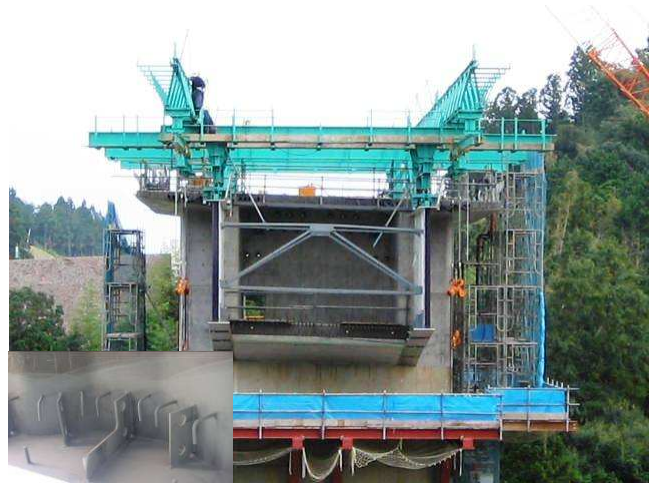
写真-3 杉谷川橋（下り線）
