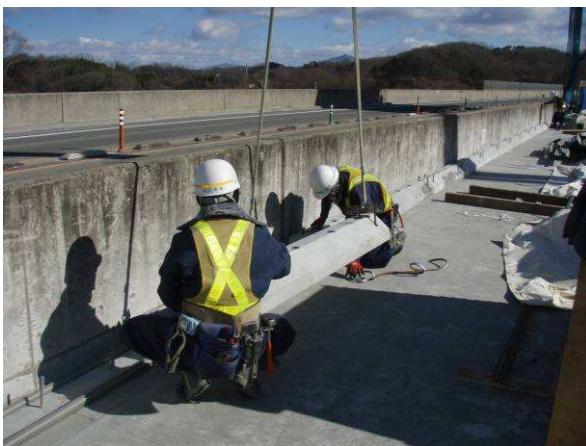
写真-17 プレキャスト地覆敷設
