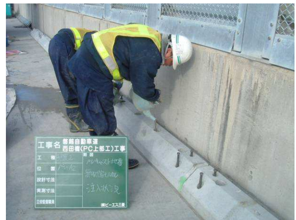
写真-18 無収縮モルタル充てん
