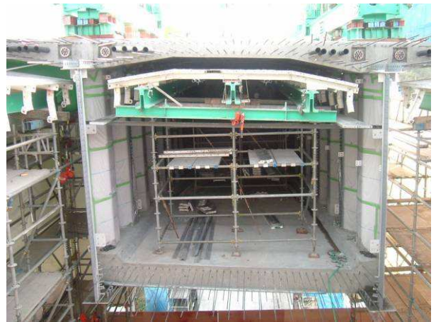
写真-14 張出し架設中の桁断面
