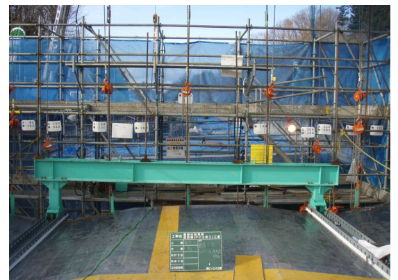
写真-5 下床版コンクリート荷重支持梁
