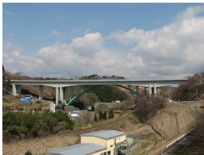
写真-20 完成写真
